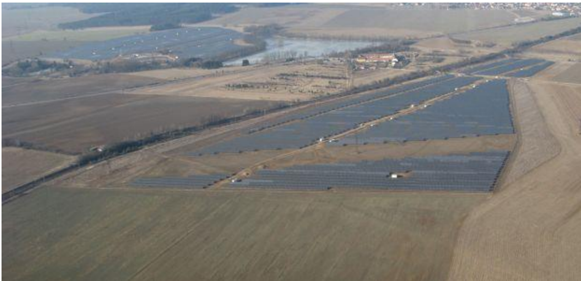
Obr. 22 Fotovoltaická elektrárna Ševětín [72]
