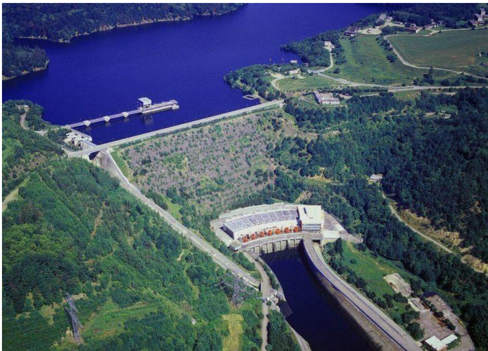
Obr. 10 Přečerpávací vodní elektrárna Dalešice [12]
