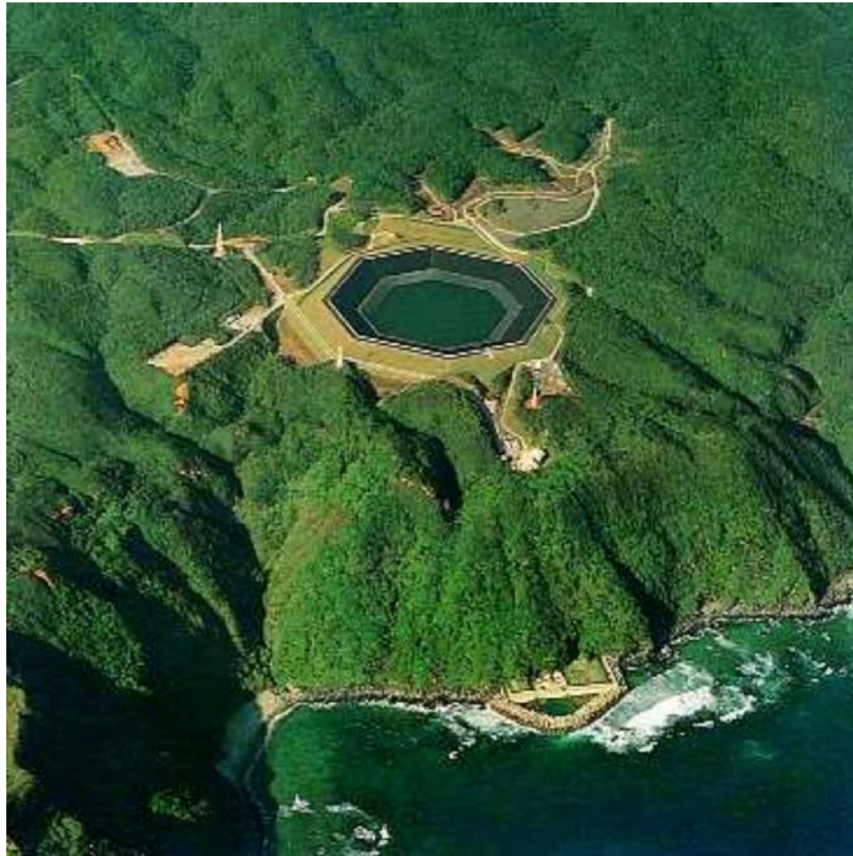
Obr. 13 Mořská přečerpávací vodní elektrárna Okinawa Yambaru [49]
