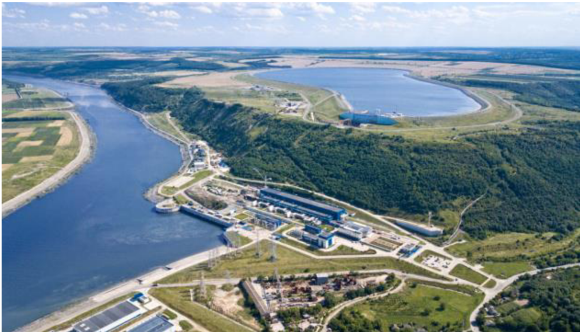
Obr. 12 Přečerpávací vodní elektrárna Dněstr PSP [44]
