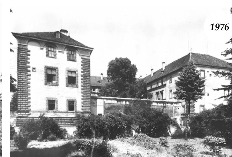
Obr. 89 - Pohled na jižní stranu s vyhládkovou zídou a parkem, 1976 (převzato z: SÚRP MO. Nelahozeves - zámek: stavebně historický průzkum.1976.)
