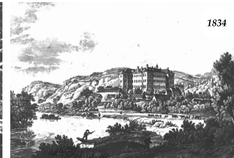
Obr. 72 - Pohled od severovýchodu, litografie, L. Buquoy, 1834 (převzato z: SÚRP MO. Nelahozeves - zámek: stavebně historický průzkum.1976.)
