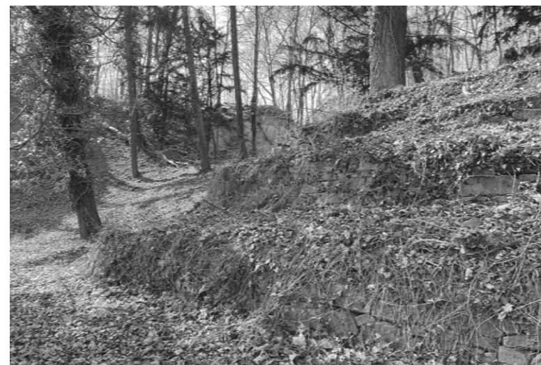
Obr. 117 - Opěrné zídky v parku (vlastní foto)
