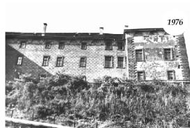
Obr. 88 - Pohled na východní průčelí a terasu, 1976 (převzato z: SURPMAO, Náhlezeves - sámek: stavební historický průzkum, 1976.)
