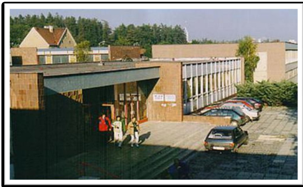
Obrázek 9. Budova Sportovního gymnázia Kladno. ( http://www.firmy.cz/detail/362494-sportovni-gymnazium-kladno-kladno-krocehlavy.html )
