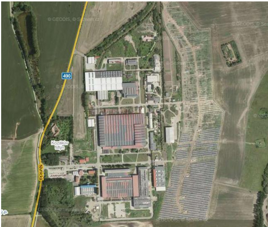
Obr. 12 Letecký pohled na Slováké strojírny a.s. a rozestavěnou FVE (Zdroj: Mapy.cz [online] 2010)
