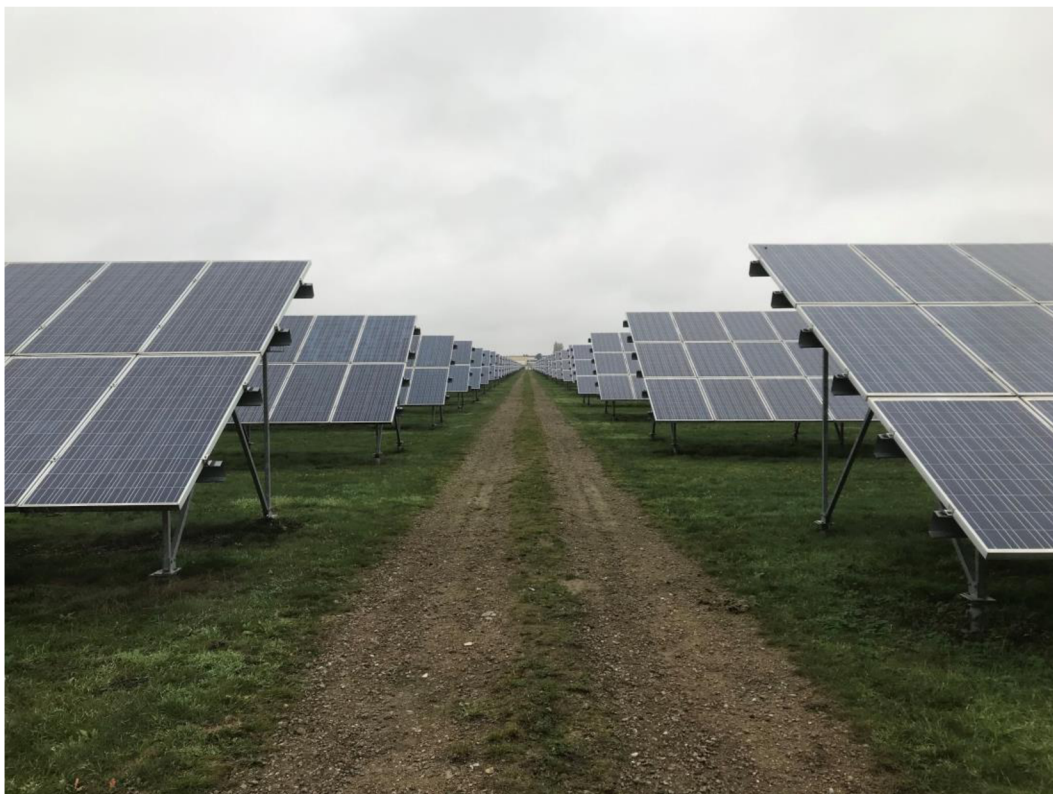
obr. 2-2 Rozostupy medzi stĺpcami – FVE Brno-Tuřany
