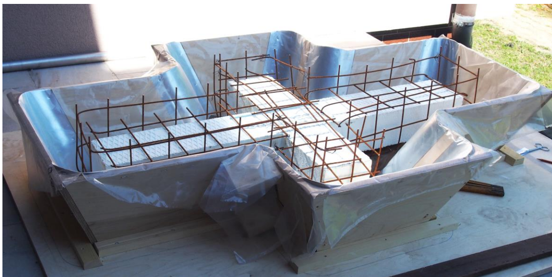
Obr. 40. Dřevěná forma a vnitřní výztuž
