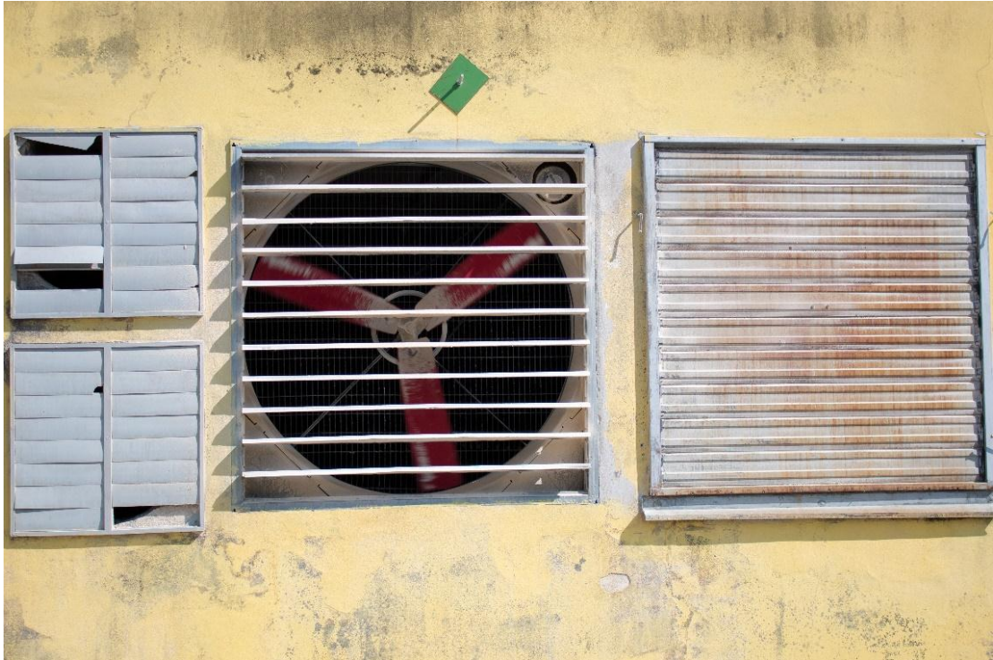
Obrázek 21: Ventilátor v hale pro chov drůbeže
