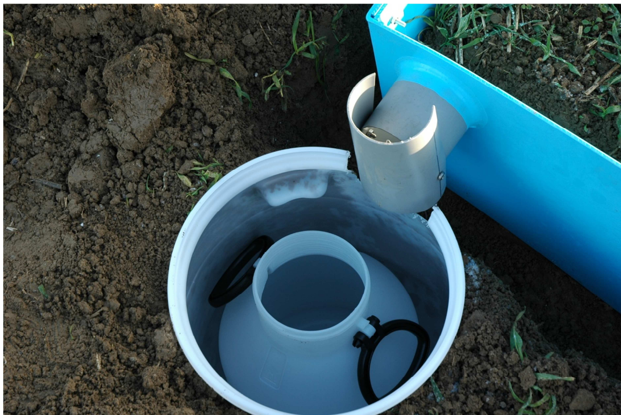
Obr. 21 Detail závěrového profilu odtokové parcely
