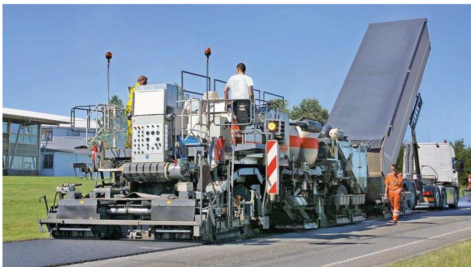
Obrázek 1.8: Recyklace na místě za horka pomocí stroje WIRTGEN [8]
