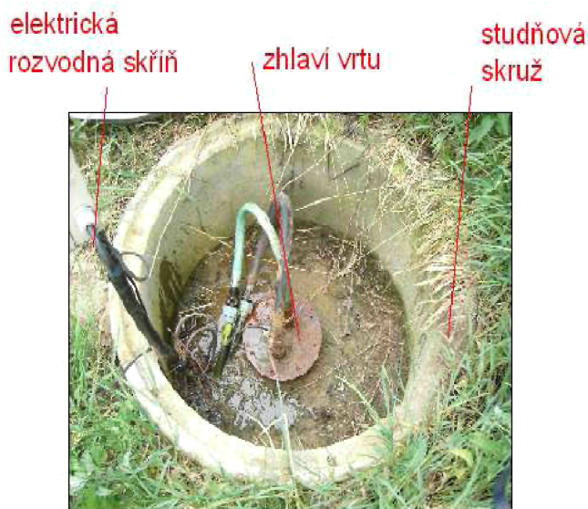
Obr.č. 7 Pohled do otevřeného hydrogeologického vrtu
