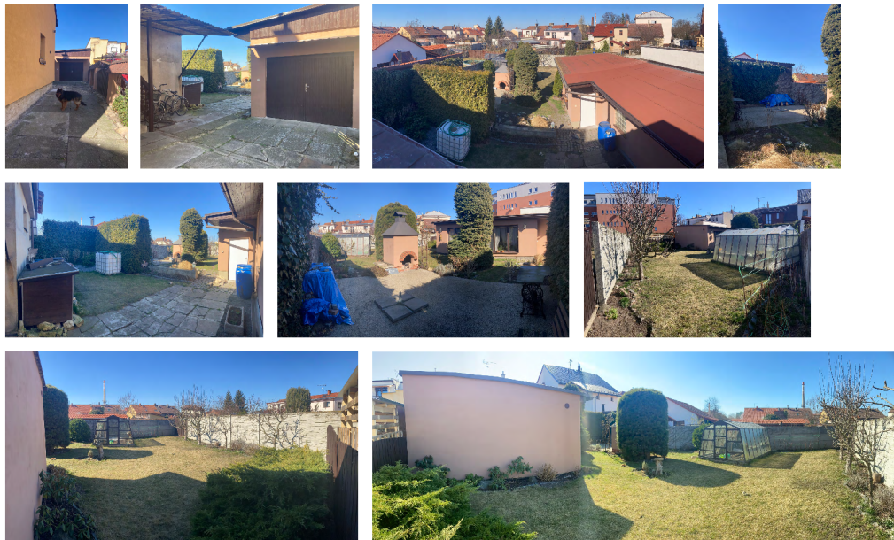
Obrázek 14 - 22: Fotodokumentace stávajícího stavu (zdroj: autor práce)
