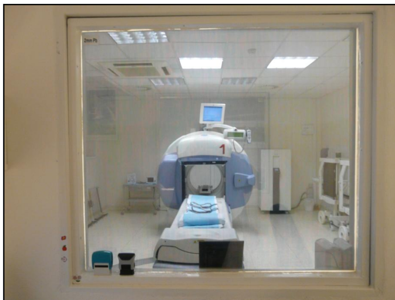
Obrázek č. 11 : Stínící stěna s barytovou omítkou a pozorovacím okénkem z Pb skla
