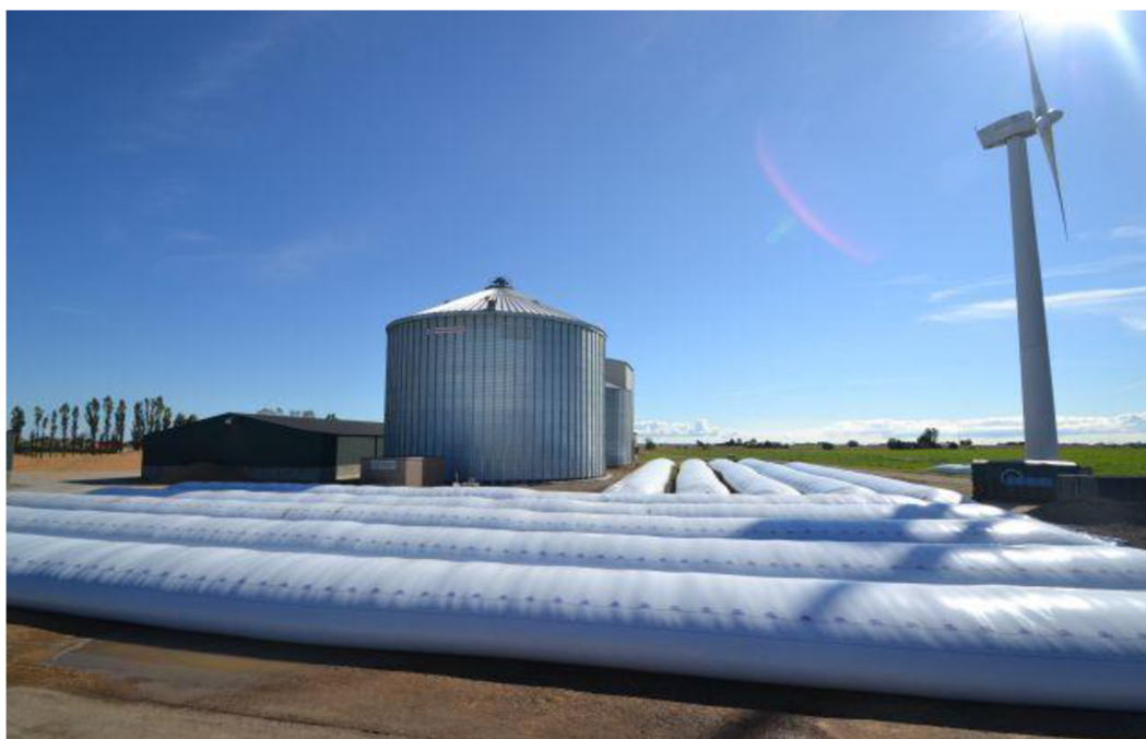
Obr. 1.3 Skladování obilnin pomocí vaků [1].
