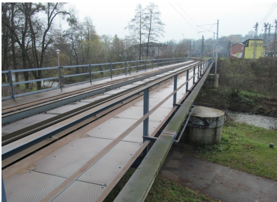
Obr. 1.1 Pohľad na most v smere do stanice Zábřeh na Moravě
