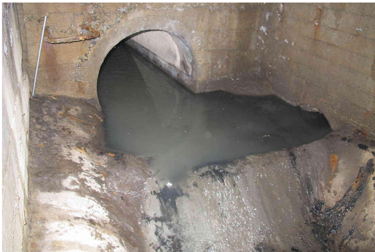
Obr. 2.4 Odlehčovací komora s čelním přepadem – OK Orlovská (ČOV Heřmanice II) v Ostravě
