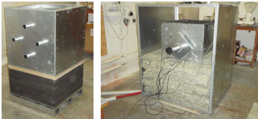
Obr. 3 Fotografie z průběhu výstavby prototypu tepelného úložiště. Vlevo jádro úložiště bez rozdělovacího prvku vzdušného výměníku, vpravo již probíhá zaizolování akumulčního jádra i spolu s prvky výměníku.
