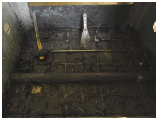
Obr. 1 Fotografie ze stavby akumulčního jádra. Konglomerát granitových kostek a TVG. (Lachman et al., 2014)
