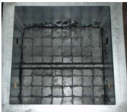
Obr. 1 Fotografie ze stavby akumulčního jádra. Konglomerát granitových kostek a TVG. (Lachman et al., 2014)
