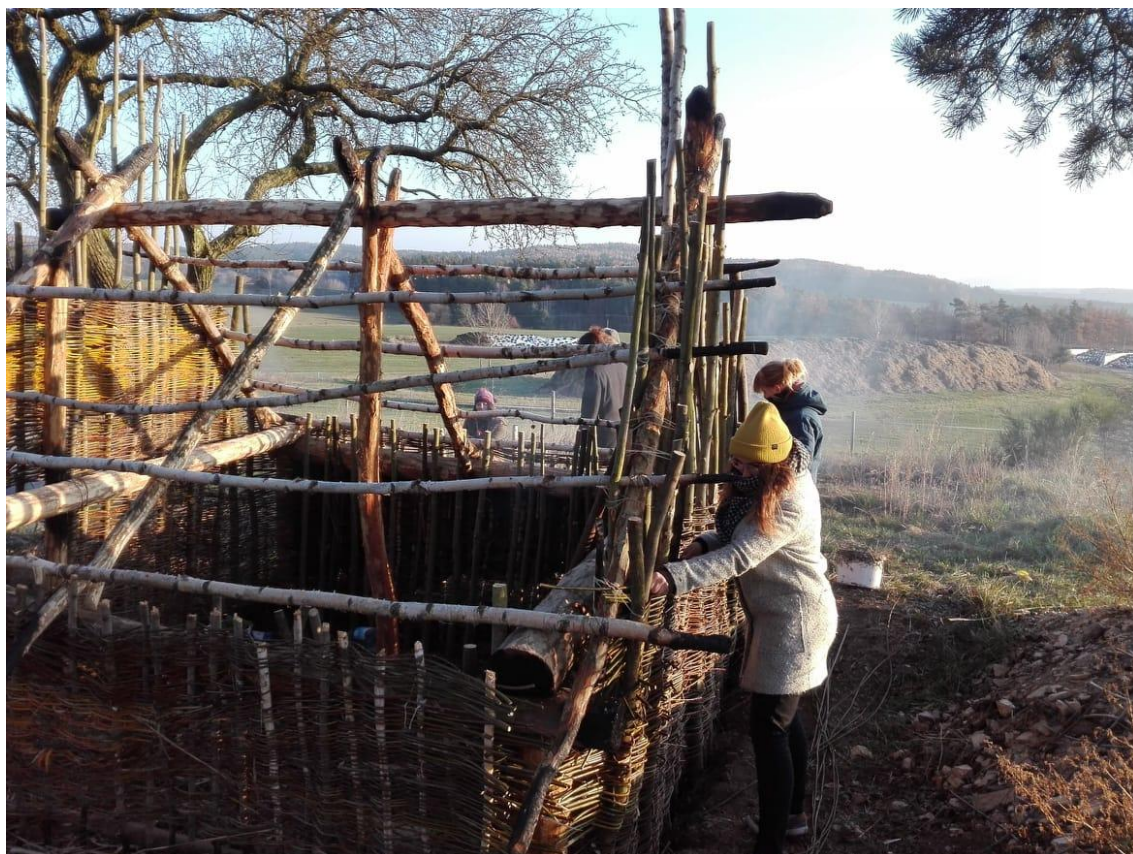
Obr. č. 21 – Vyplétání objektu vrbovým proutím (foto: J. Valešová)
