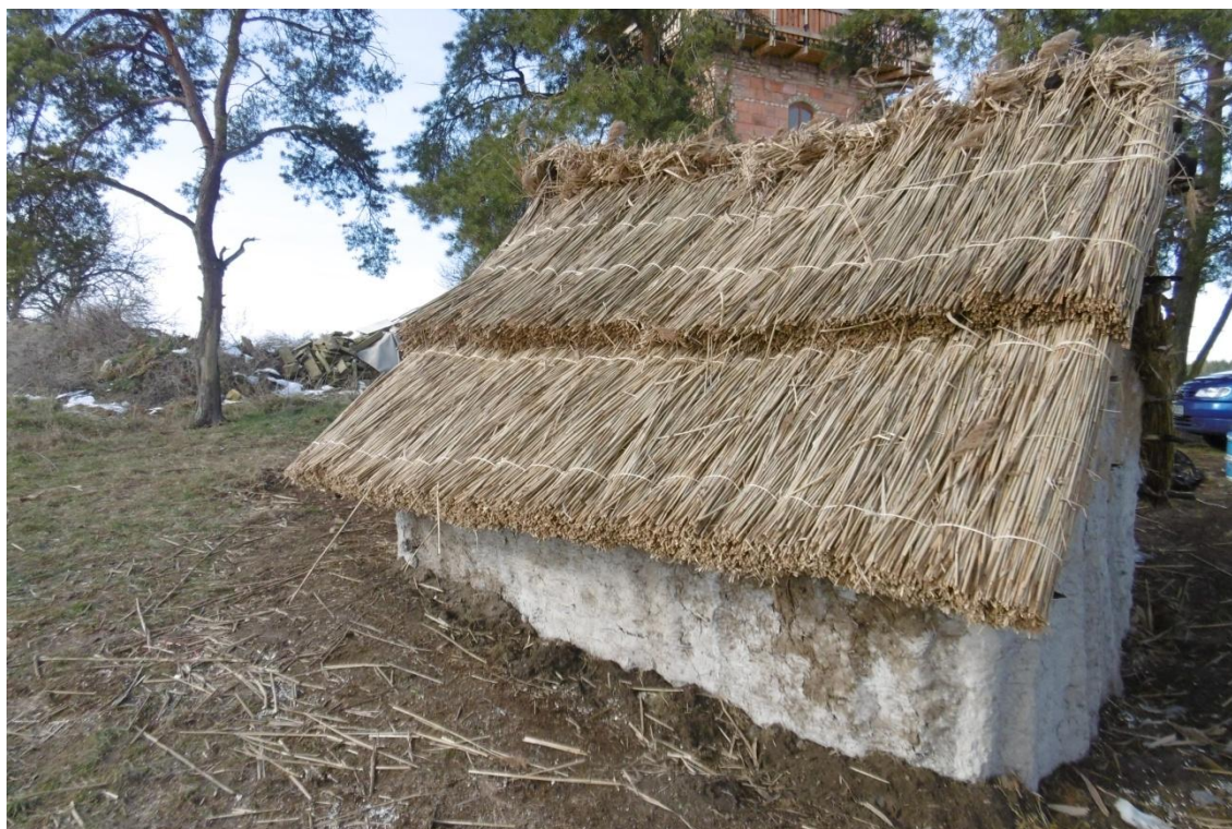
Obr. č. 27 – Pohled na jižní střešní rovinu (foto: J. Valešová)
