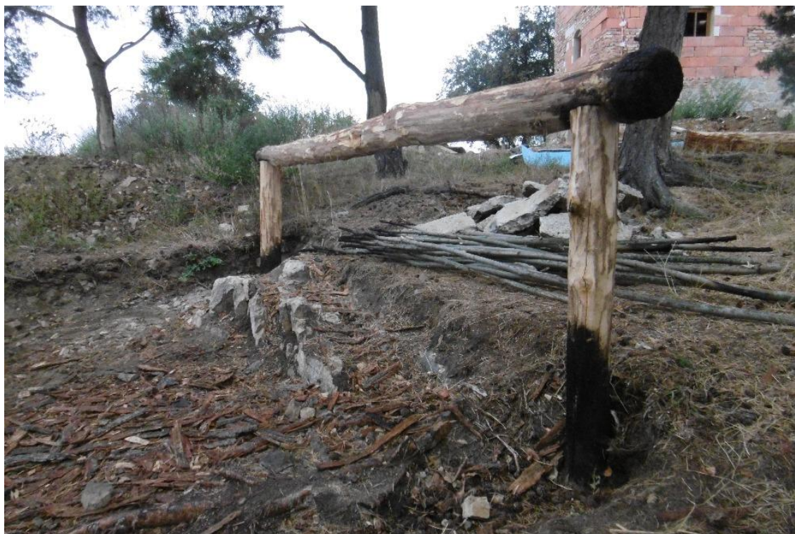
Obr. č. 15 – Osazení okapových vaznic (foto: J. Valešová)
