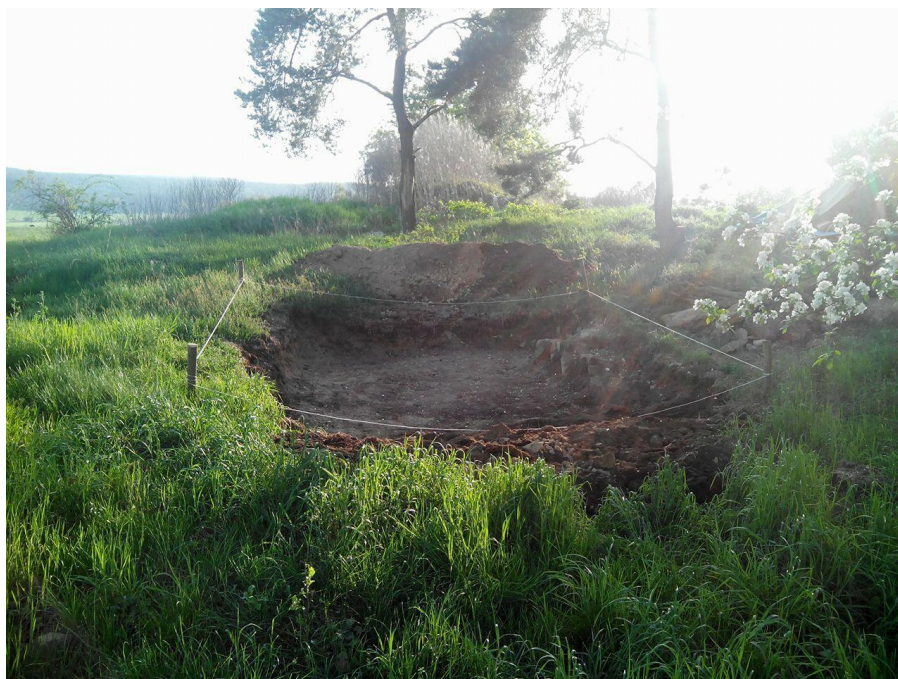
Obr. č. 8 – Pohled na základový výkop (foto: J. Valešová)
