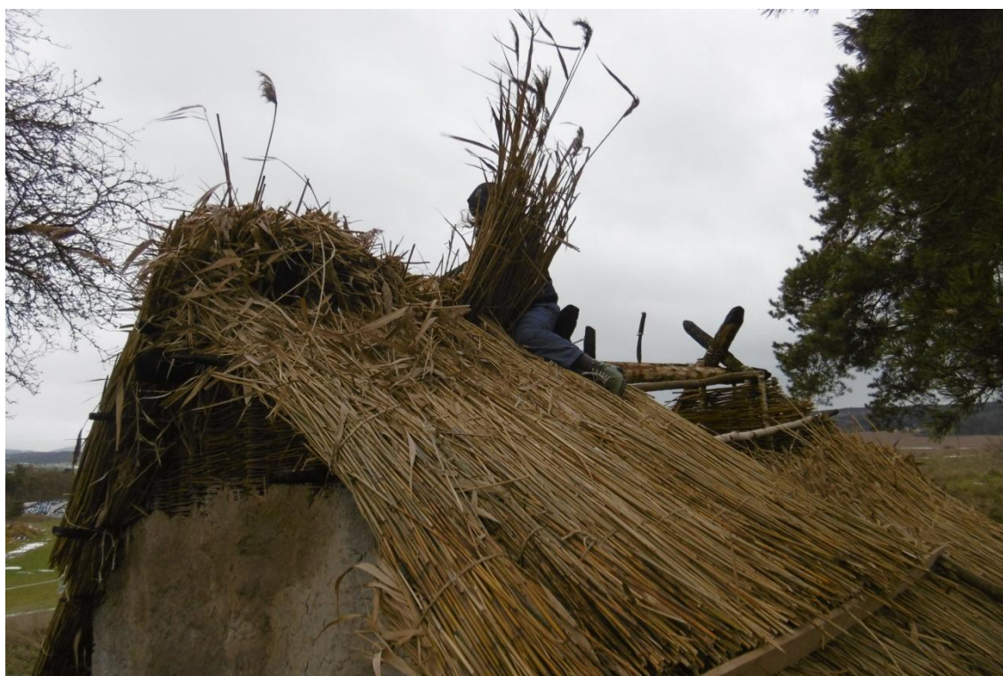
Obr. č. 26 – Splétání copu v hřebenu střechy (foto: J. Valeš)
