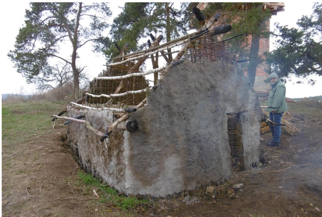
Obr. č. 23 – Pohled na omazané stěny objektu (foto: J. Valešová)
