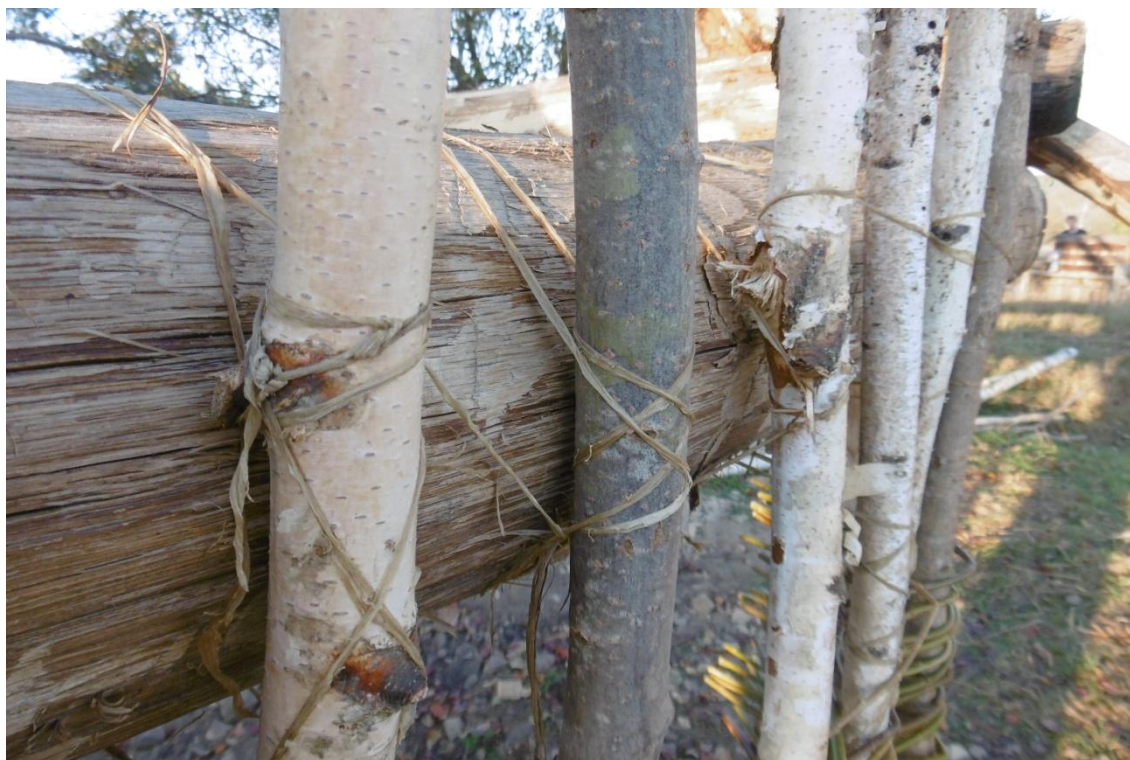
Obr. č. 19 – Upevnění nosné konstrukce stěn, vepřová střeva (foto: J. Valešová)
