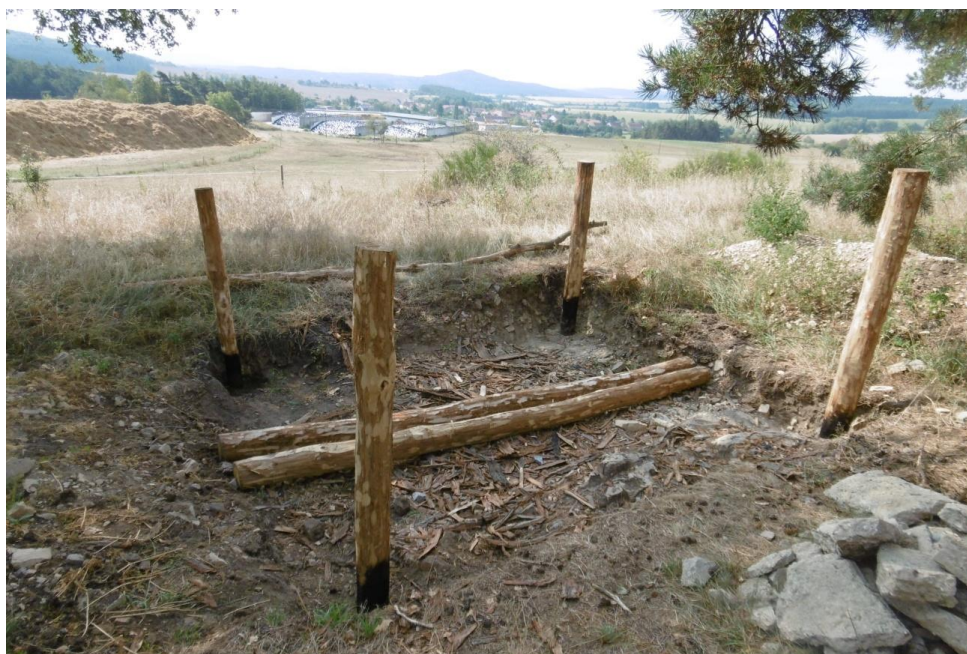
Obr. č. 12 – Osazení čtyř rohových sloupů – odkorněných (foto: J. Valešová)
