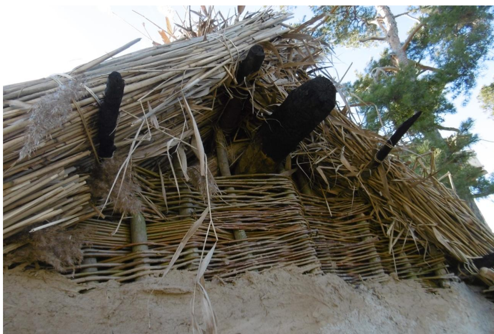
Obr. č. 30 – Pohled na dýmny otvor (foto: J. Valešová)
