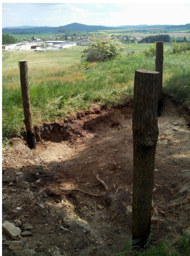
Obr. č. 9 – Osazení tří rohových sloupů (foto: J. Valešová)
