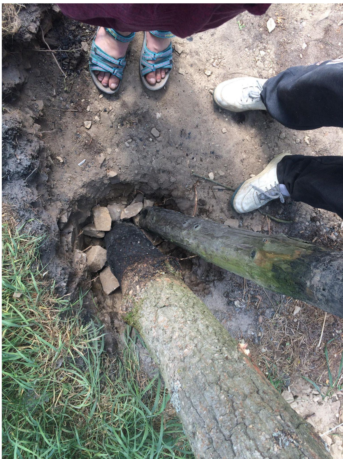
Obr. č. 10 – Osazování rohového sloupu (foto: Viktorie Vrbová)
