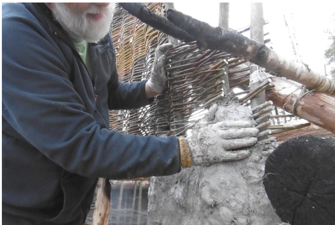
Obr. č. 22 – Omazávání stěn objektu (foto: J. Valešová)
