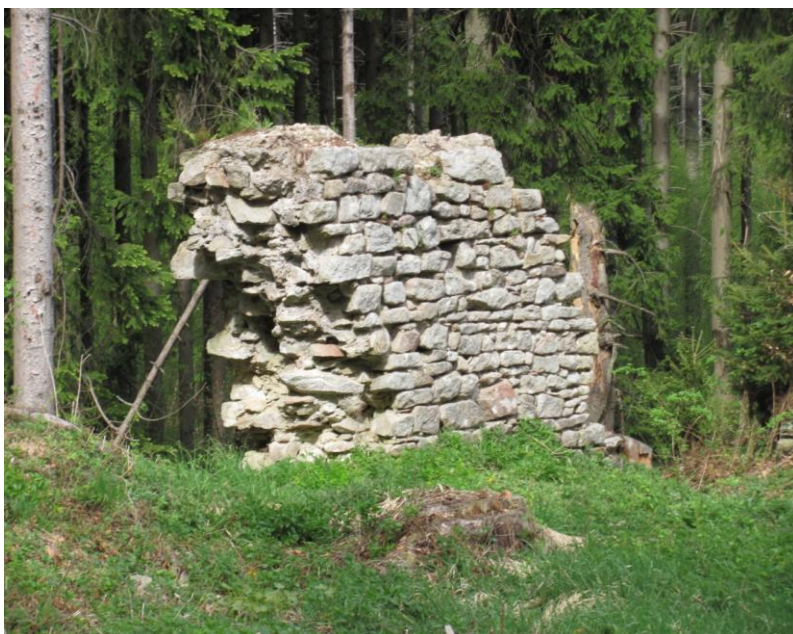
Obr. 15 - Šternberk – Zbytky severního zdiva palácové budovy (vnitřní pohled). Foto autor.
