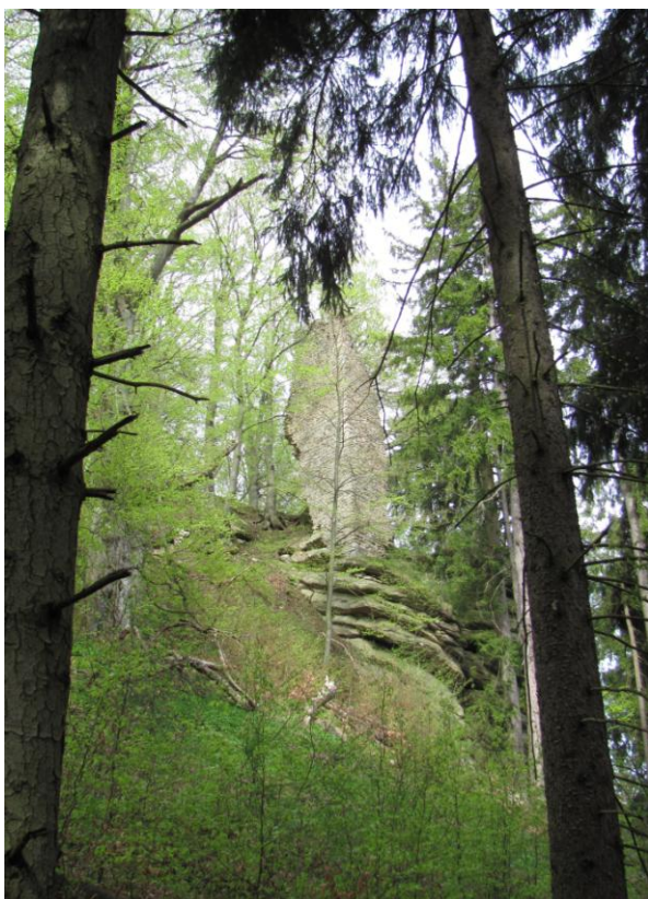
Obr. 14 – Šternberk – Dochované torzo zdiva jižní části hradu (spodní pohled). Foto autor.
