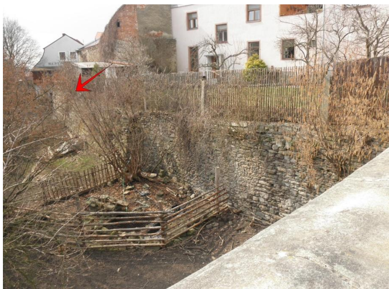
Obr. 32 - Pravděpodobná jižní hranice původního ze měpanského telečského dvorce. Foto a úprava autor.
