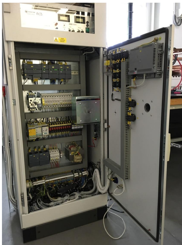
Obr. č. 27: Zapojení ovládacího zdroje
