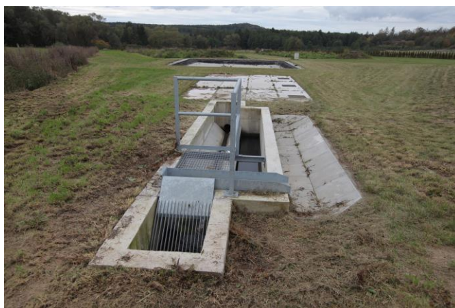
Obr. 13 Lapák písku pro ČOV 250 EO (obec Skašov)
