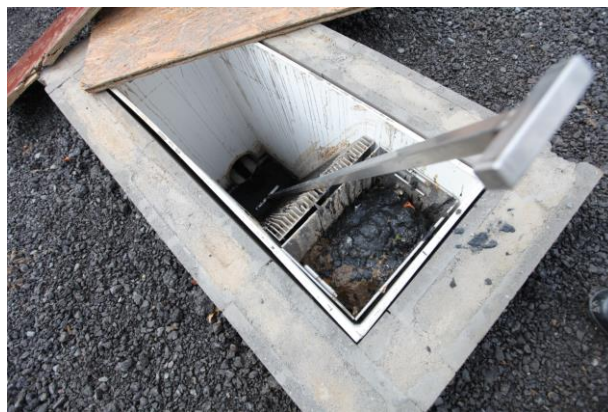
Obr. 11 Ručně stírané česle navržené v obci Cekov
