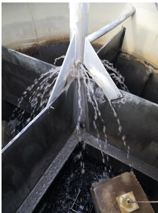
Obr. 21 Pohled do vnitřního prostoru čtyřkomorové distribuční šachty
