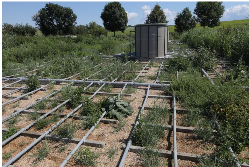
Obr. 20 Distribuční systém pro vertikální filtry (řešení chráněno užitným vzorem VUT)
