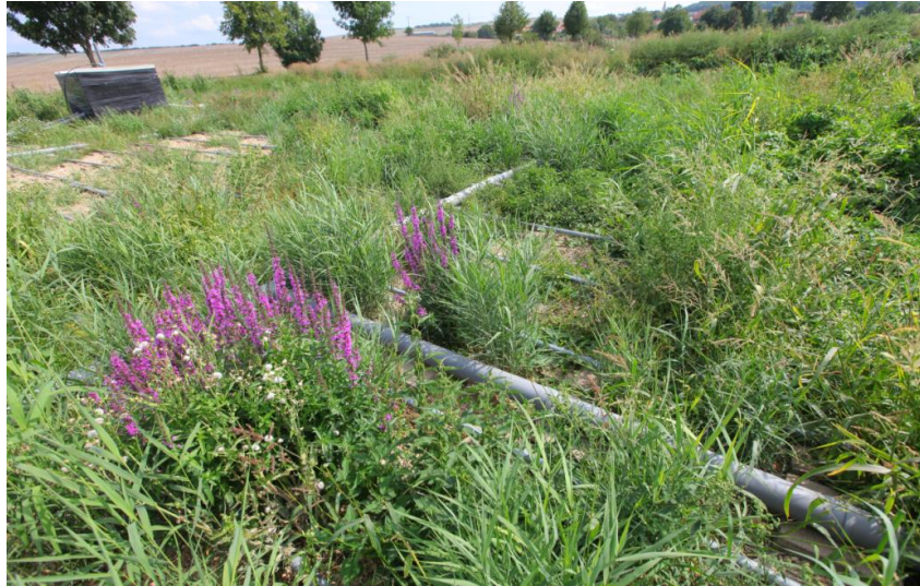
Obr. 19 Pohled na vertikální filtr po ročním provozu (obec Dražovice)
