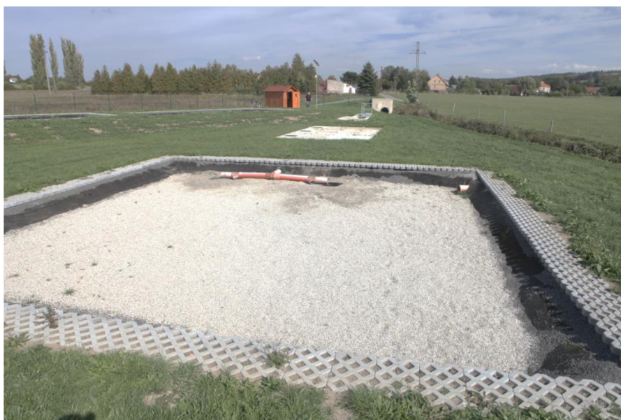
Obr. 17 Horizontální filtr bez přítomné vegetace (obec Skašov)
