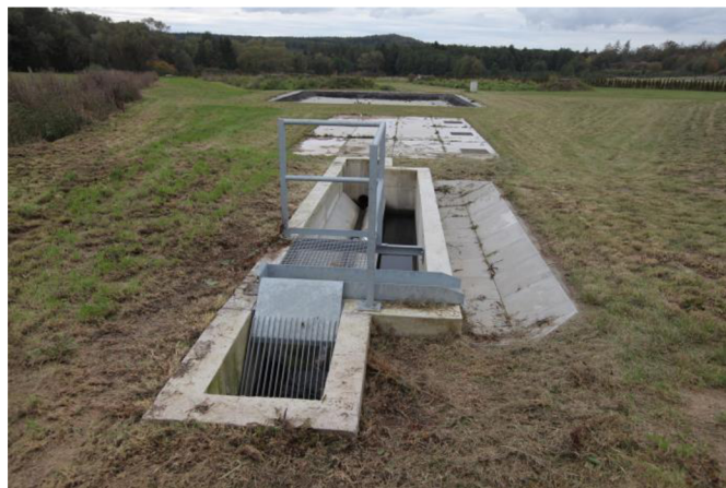
Obr. 13 Lapák písku pro ČOV 250 EO (obec Skašov)
