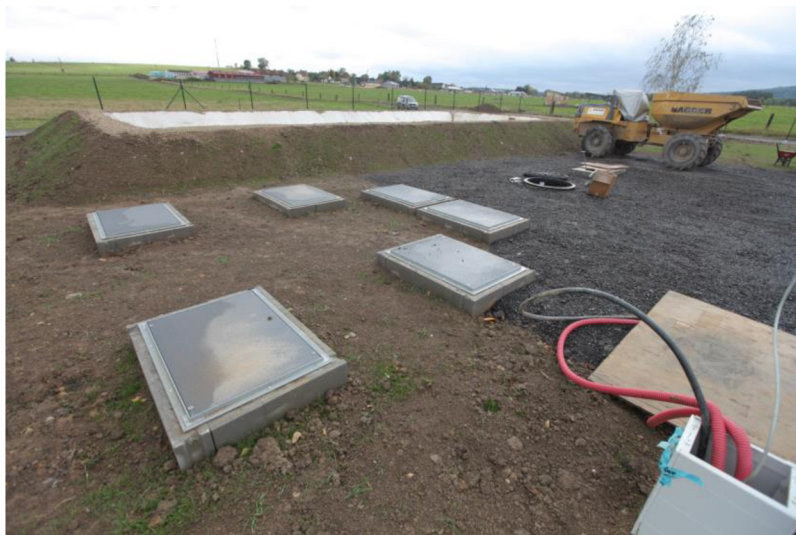
Obr. 23 Pohled na nově realizované kalové pole v blízkosti septiku
