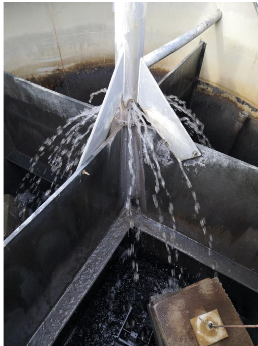
Obr. 21 Pohled do vnitřního prostoru čtyřkomorové distribuční šachty
