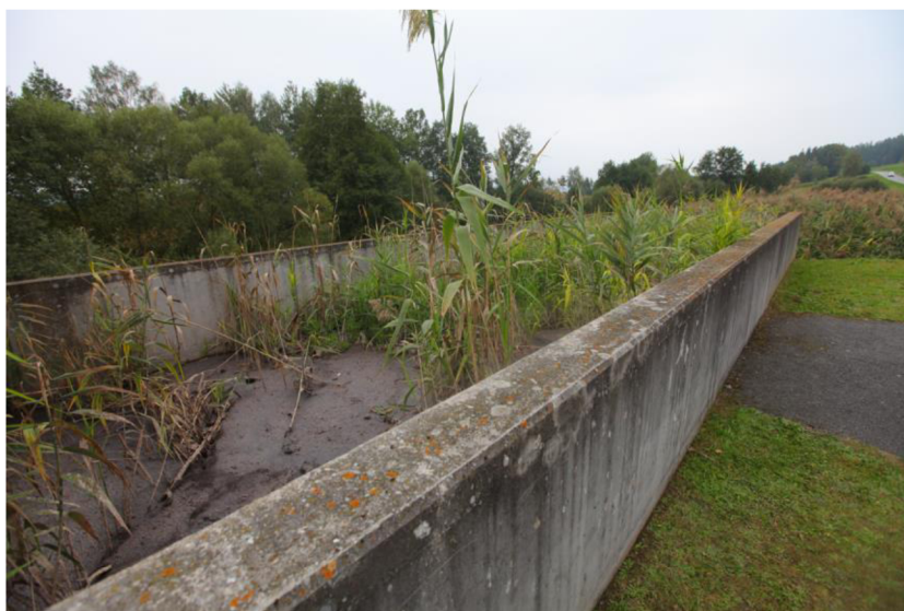
Obr. 22 Kalové pole v betonovém objektu (Rakousko, ČOV pro 120 EO, zdroj: Kriška)
