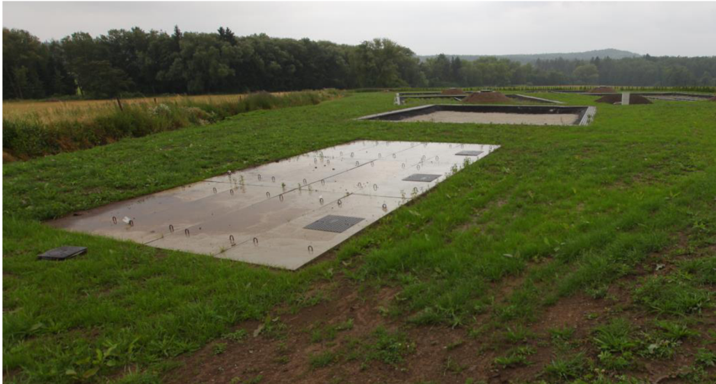
Obr. 14 Velkoobjemový tříkomorový septik jako monolitická ŽB nádrž realizovaná na místě (obec Skašov)
