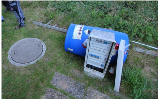
Obr. 12 Jednotka pro srážení fosforu (ČOV pro 80 EO, Rakousko)
