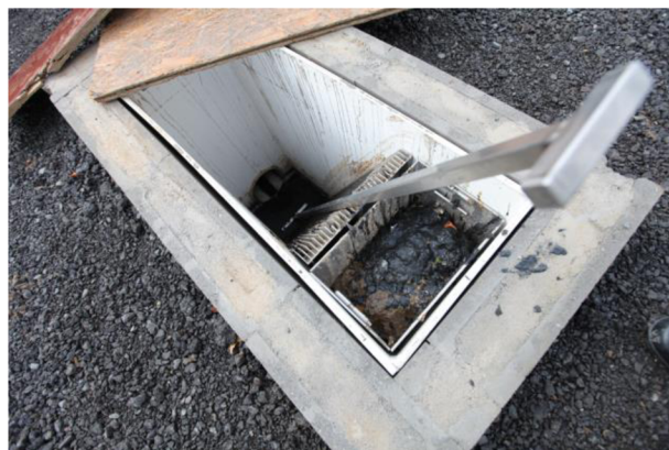
Obr. 11 Ručně stírané česle navržené v obci Cekov
