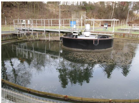
Obr. 5.5.2.9. Pohled na novou dosazovací nádrž [10]
