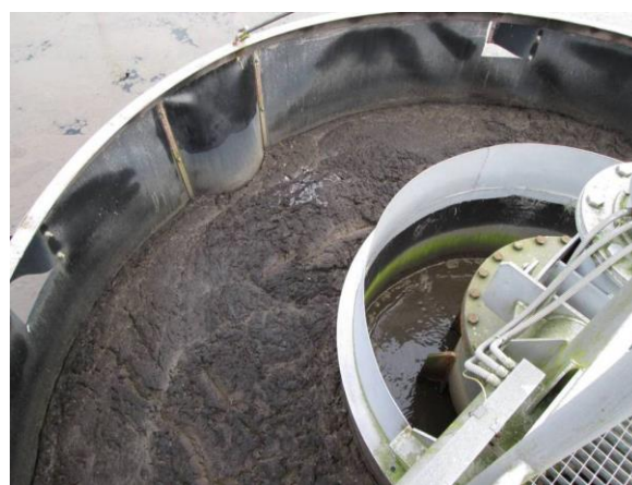
Obr. 5.5.2.12. Pohled na přívod odpadní vody [10]
