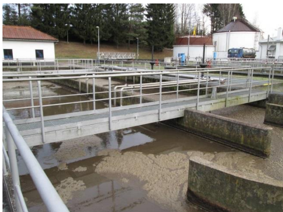
Obr. 5.5.2.3. Pohled na novou aktivační nádrž, vlevo vzadu nová dmýchána, vpravo vzadu plynojem a vyhnívací nádrž [10]
