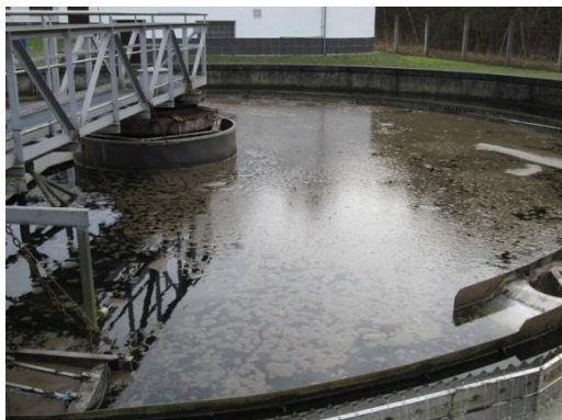
Obr. 5.5.2.6. Pohled na původní dosazovací nádrž [10]
