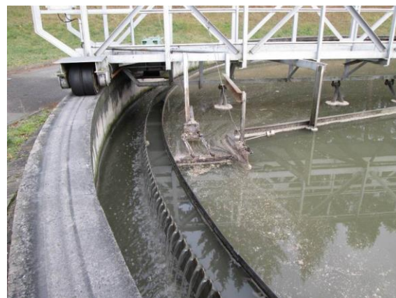
Obr. 5.5.1.4. Detail pojezdového mostu a stíracího zařízení plovoucích nečistot usazovací nádrže [10]
