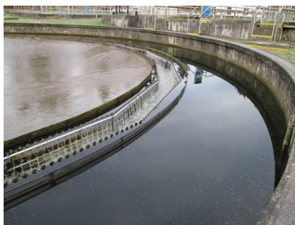
Obr. 5.5.2.8. Pohled na odtok z původní usazovací nádrže [10]
