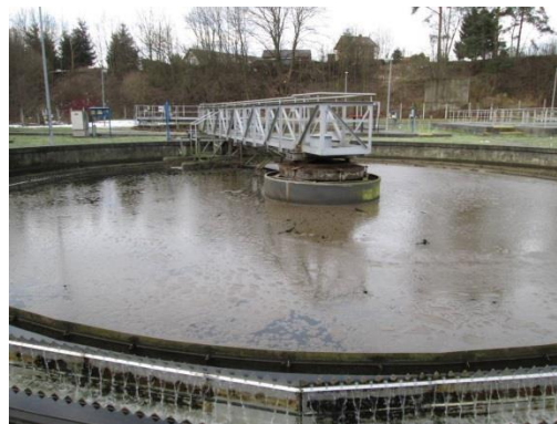
Obr. 5.5.2.7. Celkový pohled na původní dosazovací nádrž [10]
