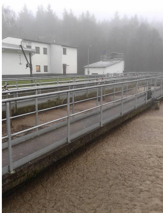
Obr. 5.5.2.2. Pohled na přítokové potrubí do původní AN, v popředí pohledové betony původní AN [10]
