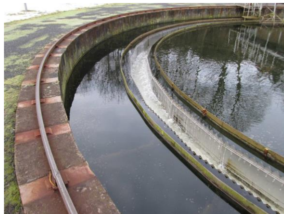
Obr. 5.5.2.10. Pohled na odtokový kanál dosazovací nádrže [10]
