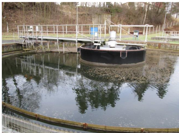
Obr. 5.5.2.9. Pohled na novou dosazovací nádrž [10]
