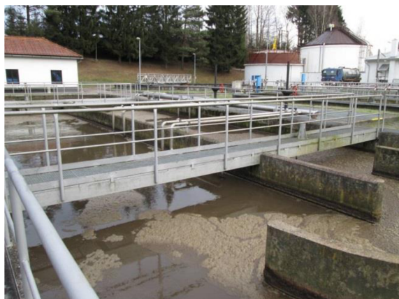
Obr. 5.5.2.3. Pohled na novou aktivační nádrž, vlevo vzadu nová dmýchána, vpravo vzadu plynojem a vyhnívací nádrž [10]
