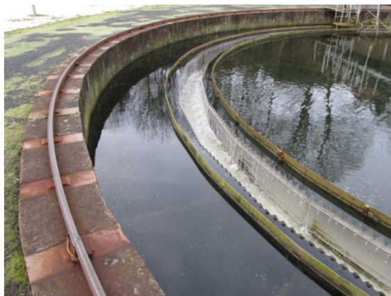
Obr. 5.5.2.10. Pohled na odtokový kanál dosazovací nádrže [10]
