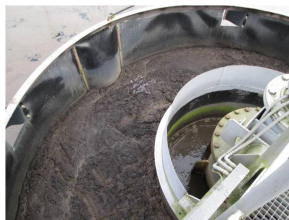
Obr. 5.5.2.12. Pohled na přívod odpadní vody [10]
