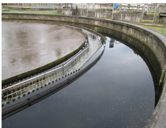
Obr. 5.5.2.8. Pohled na odtok z původní usazovací nádrže [10]
