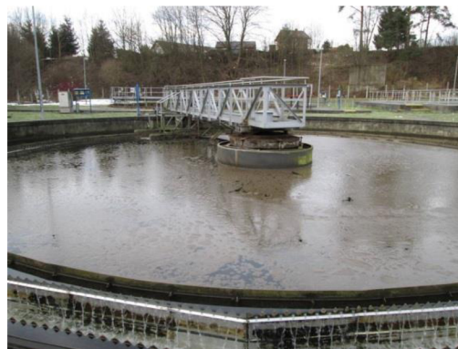
Obr. 5.5.2.7. Celkový pohled na původní dosazovací nádrž [10]
