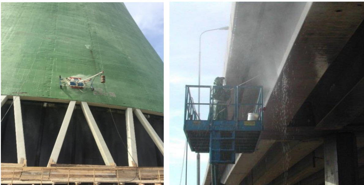
Obrázek 14 Sanace chladicí věže a mostu [14]
