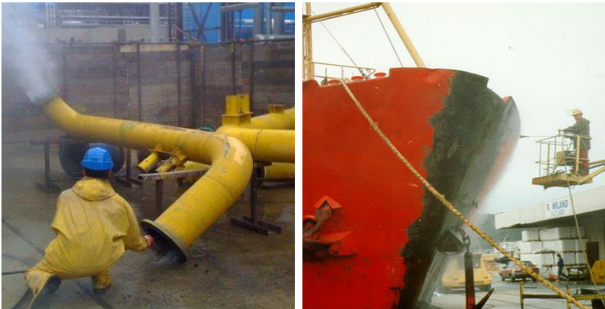
Obrázek 13 Vysokotlaké čištění potrubí a odstranění nátěru z lodi [14]
