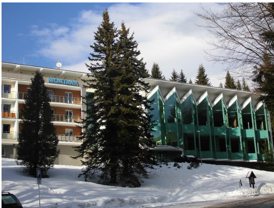
Obr. 15 Zrekonstruovaný interhotel Montana v roce 2017
