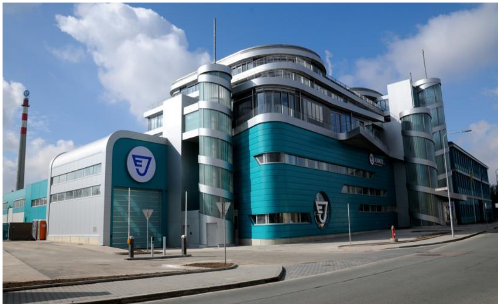
Obrázek č. 1: Pohled na firmu Erwin Junker Grinding Technology a. s. v Holicích
