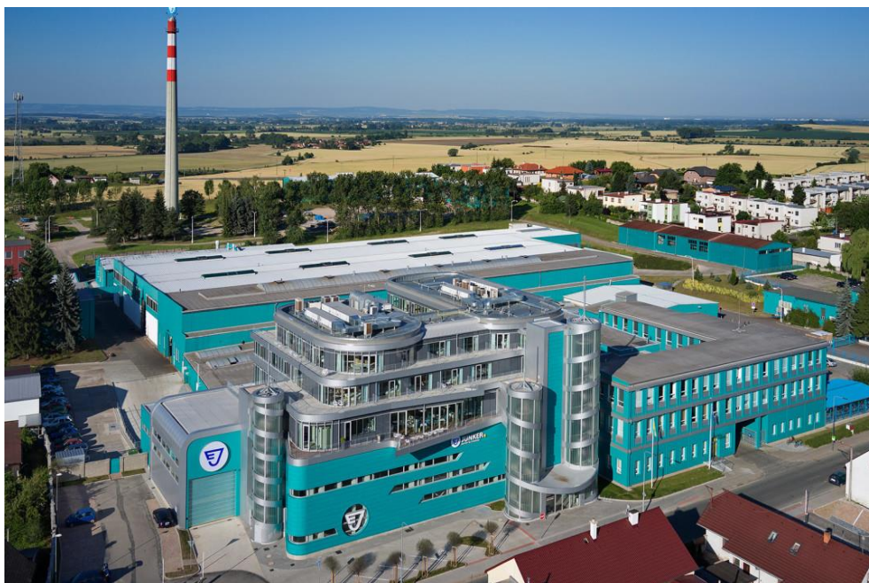
Obrázek č. 2: Letecký pohled na firmu Erwin Junker Grinding Technology a. s. v Holicích
