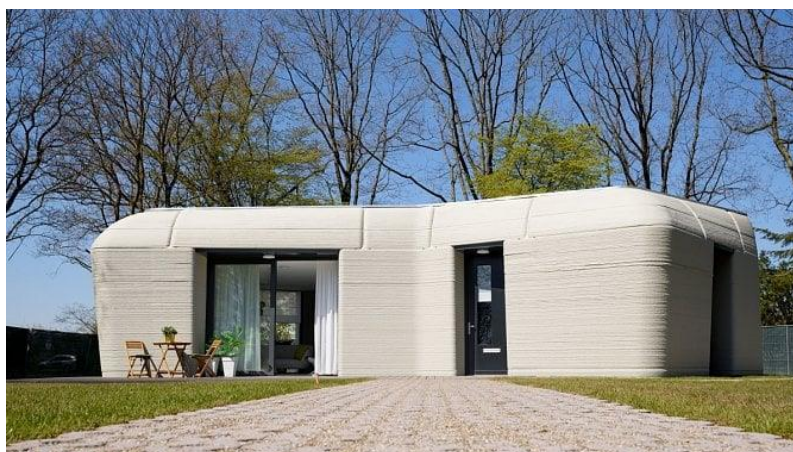
Obrázek 1 - Vytištěný dům pomocí 3D tisku (6)
