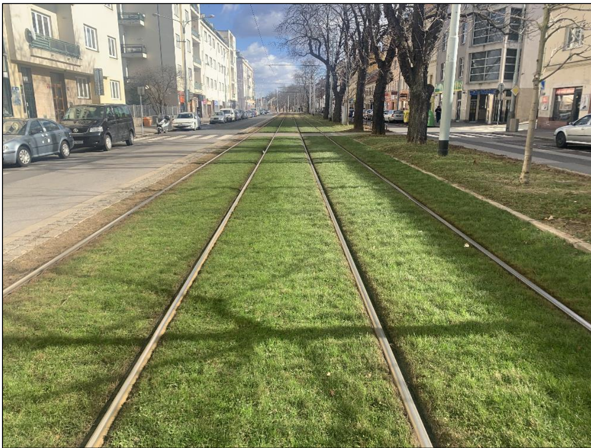
Obrázek č. 4 Bělohorská ulice v Praze po pokládce testovacích travních směsí (2022)
