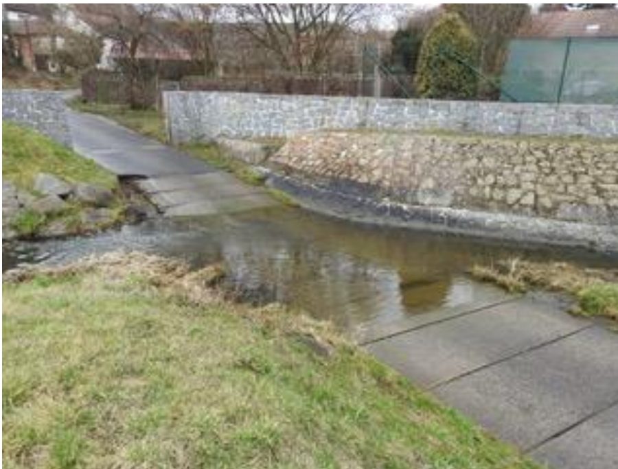
Pohled na brod a přerušení protipovodňových zdí
