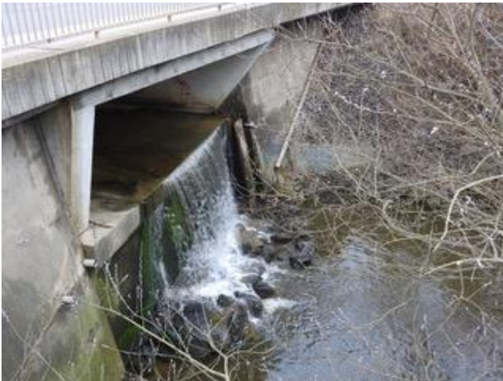
Pohled na přemostění se spádovým stupněm
