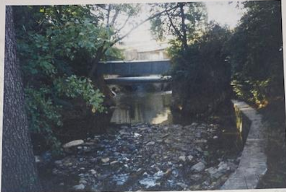
Obr.č.9 pohled do vývaru bezpečnostního přelivu Mlýnského rybníka
