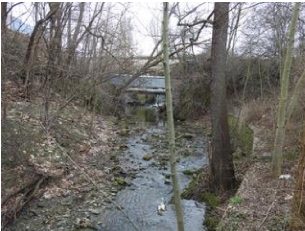
Neupravená část potoka, vzadu je pohled na most se spádovým stupněm
