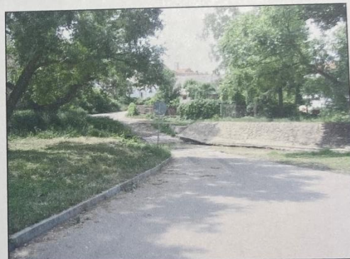
Brod v korytě Stroupinského potoka v Žebráku v km 10.210
