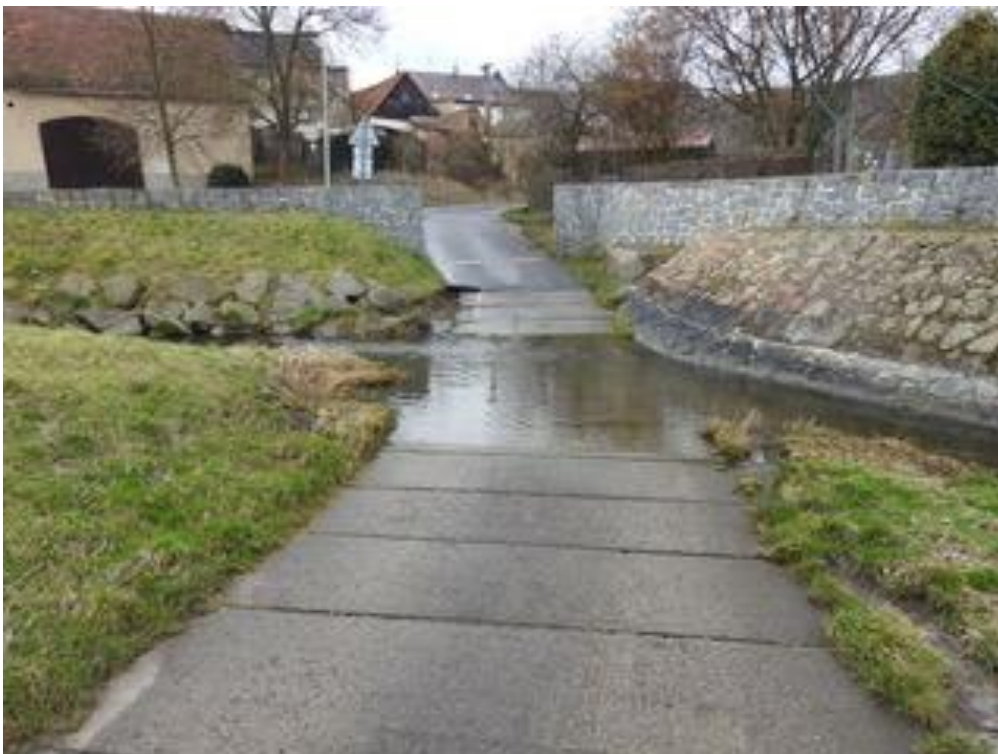
Pohled na brod a přerušení protipovodňových zdí
