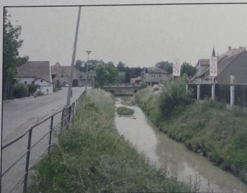
Koryto Stroupinského potoka pod mostem v Žebráku nad km 10.600
