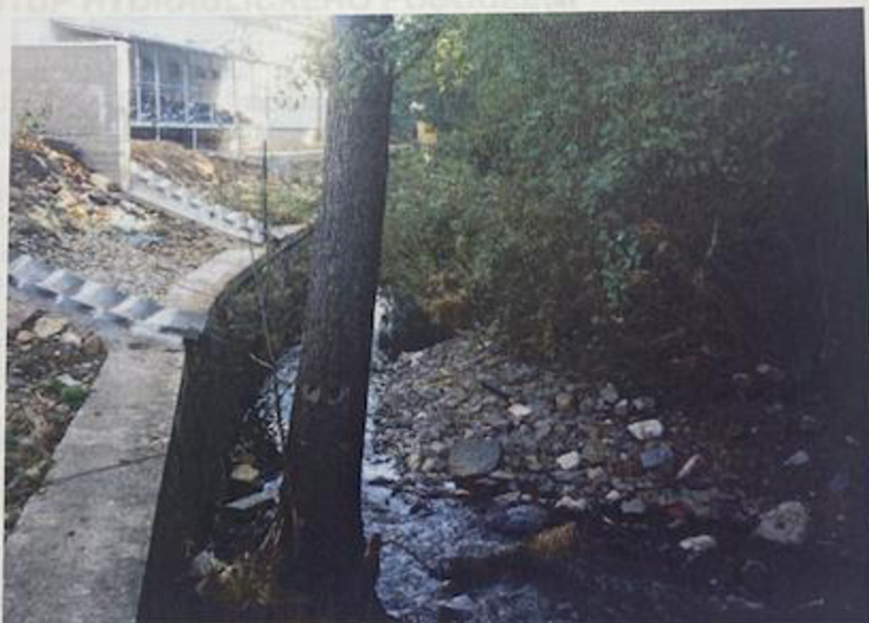
Obr.č.9 pohled po vodě z km cca 0,850
