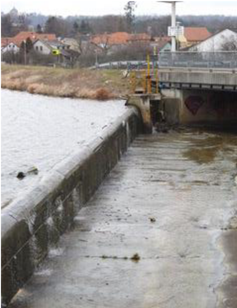
Žebrácký rybník – bezpečnostní přeliv a přemostění se spádovým stupněm
