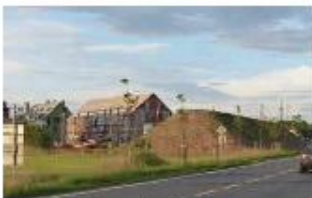
Odhlužující val z omítky po výstavbě bytových domů.
