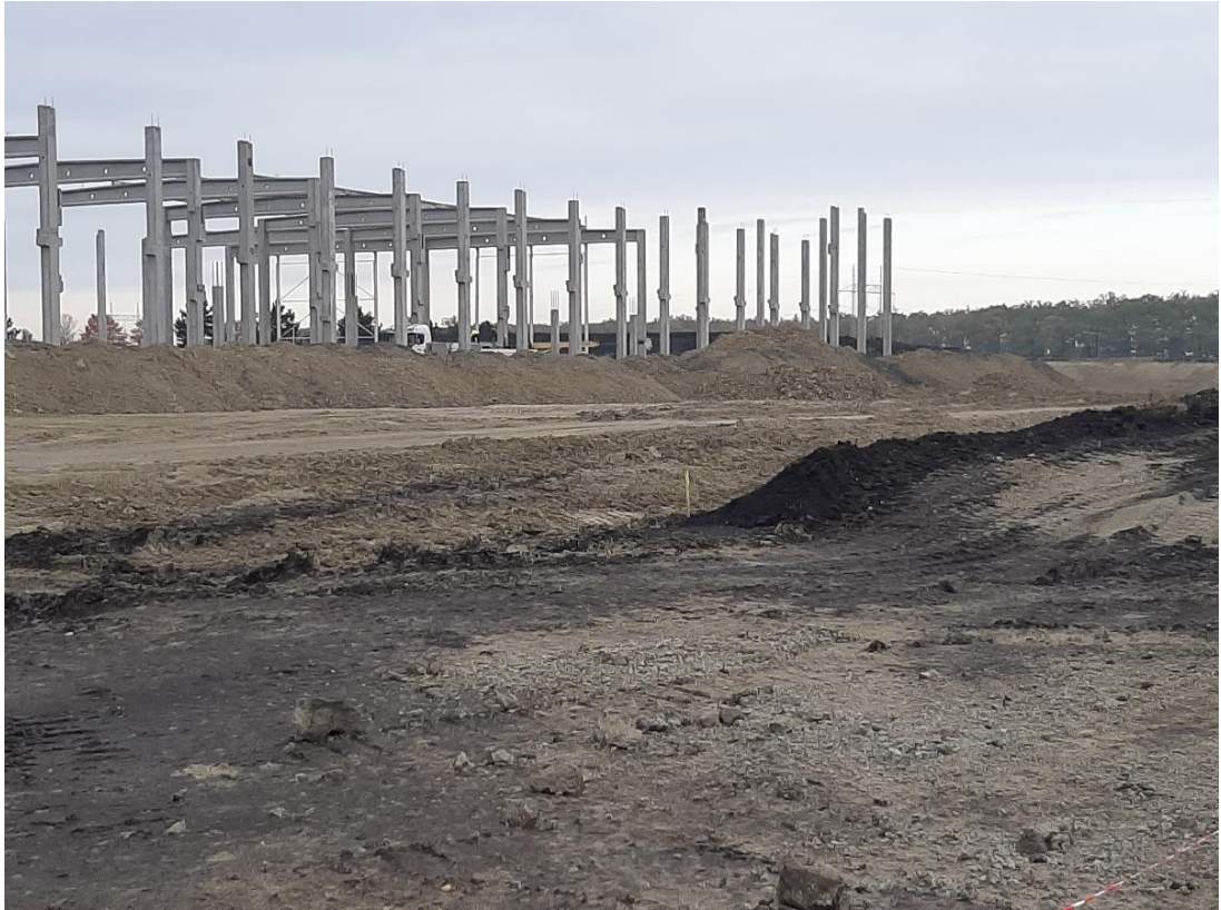
Obrázek 71: Výstavba haly (foto autorka, říjen 2022).
