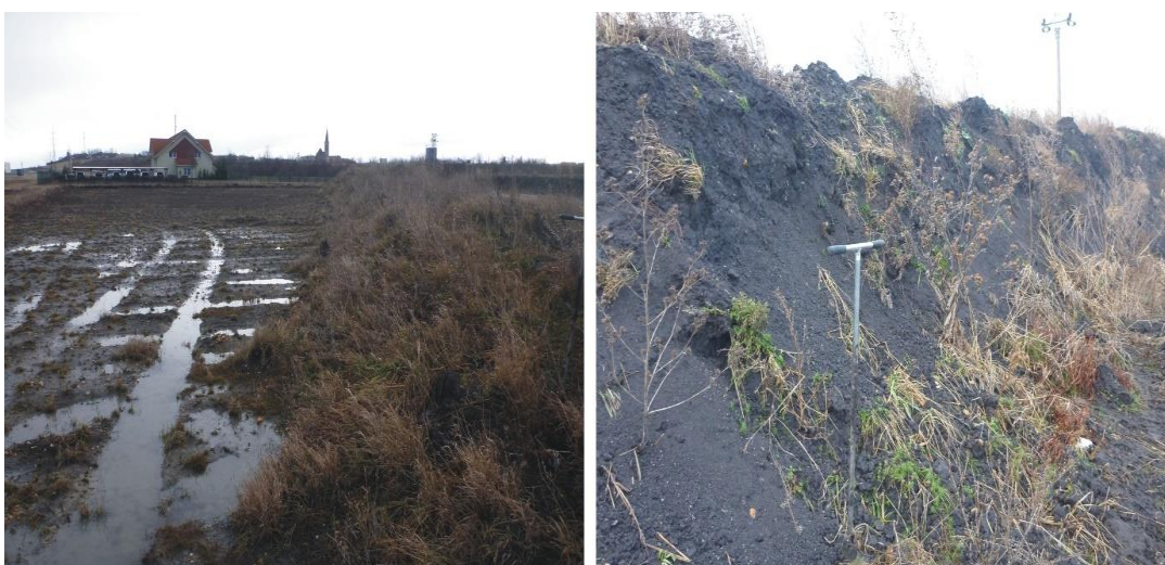
Obrázek 22: Skryté pozemky a vpravo detail deponie tvořené ornici (foto autorka ve spolupráci s VÚMOP, v.v.i.).
