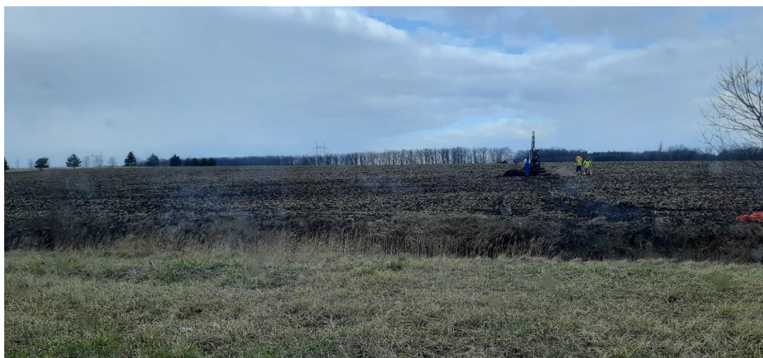
Obrázek 49: Přípravné práce výstavby haly (foto autorka, únor 2022).
