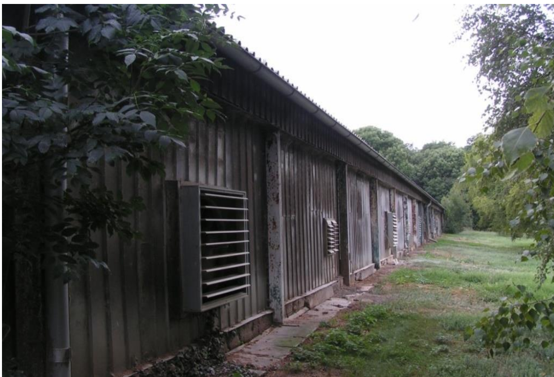
Obrázek 4.1: Hala pro výkrm brojlerů.
