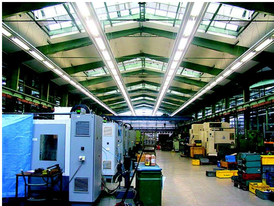
Obrázek 2.3: Zónové sálavé vytápění průmyslového haly.
