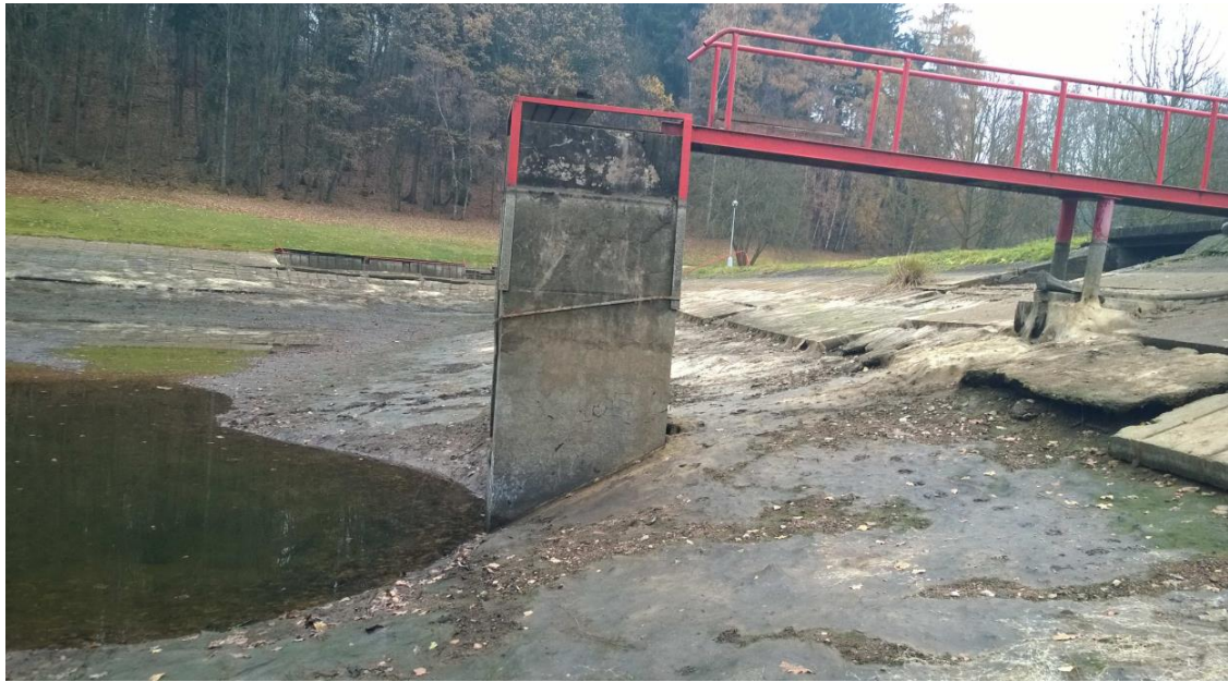
Obrázek 7: Výpustné zařízení (Tylš, 2016)
