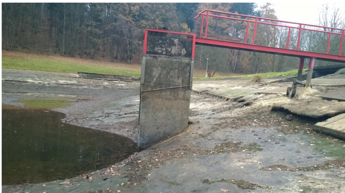
Obrázek 7: Výpustné zařízení (Tylš, 2016)
