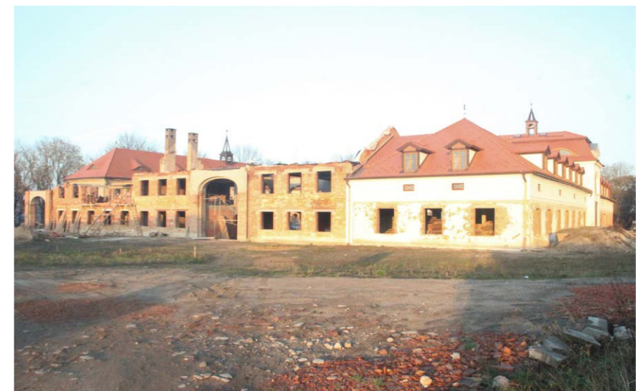
Obr. 84 Pohled na dostavbu západního průčelí
