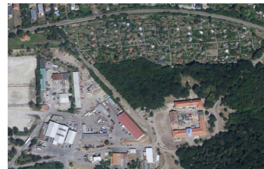
Obr. 65 Letecký snímek z roku 2017 – na západní straně usedlosti se nachází komplex výrobního a skladovacího areálu, severně zahrádkářská kolonie z 80. let, na východní straně obnovující se lesní porost. Na objektu usedlosti probíhá rekonstrukce (Národní archiv leteckých měřických snímků 2020).
