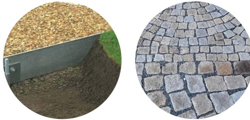
Obr. 126 Přechody mezi jednotlivými materiály jsou řešeny pomocí ocelové pásoviny Higrade, výška 150 mm (Kinley. 2020).
