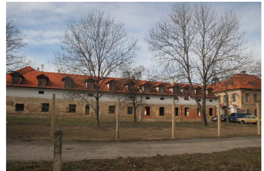
Obr. 82 Pohled na východní průčelí a vyčištěný okolní prostor
