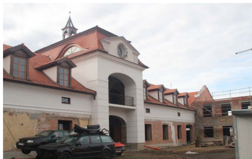
Obr. 81 Čtvercový dvůr o rozměrech 42 x 49 metrů během rekonstrukce.
