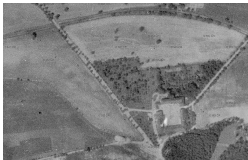
Obr. 63 Letecký snímek z roku 1938 – usedlost se už nenachází uprostřed lesů, les na východní a západní straně je vykácen. Plocha krajinářského parku je ze severní strany redukována (Národní archiv leteckých měřických snímků 2020).
