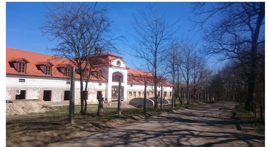
Obr. 83 Pohled na jižní průčelí s obnovovým mostkem
