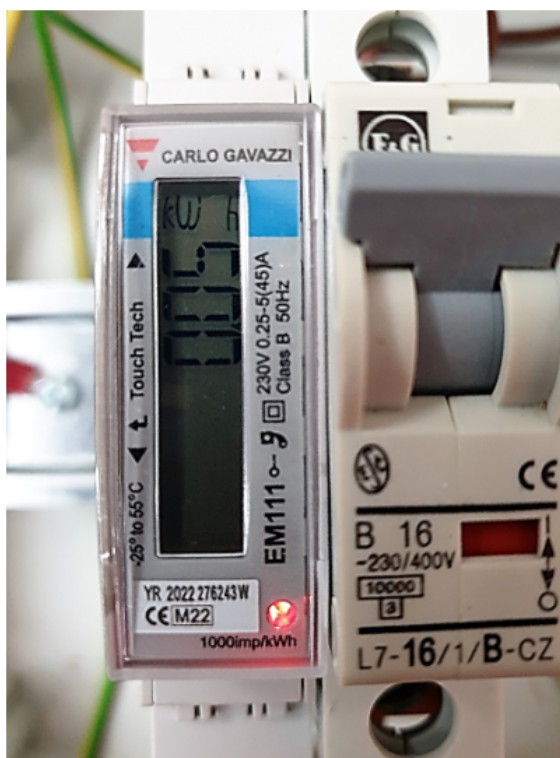
Obrázek 18.8: Odečet hodnot zobrazovaných na displeji EM111
