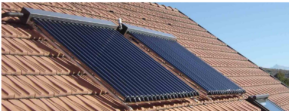
Obr. 3.4 Kolektory s vakuovými trubicemi [17]
