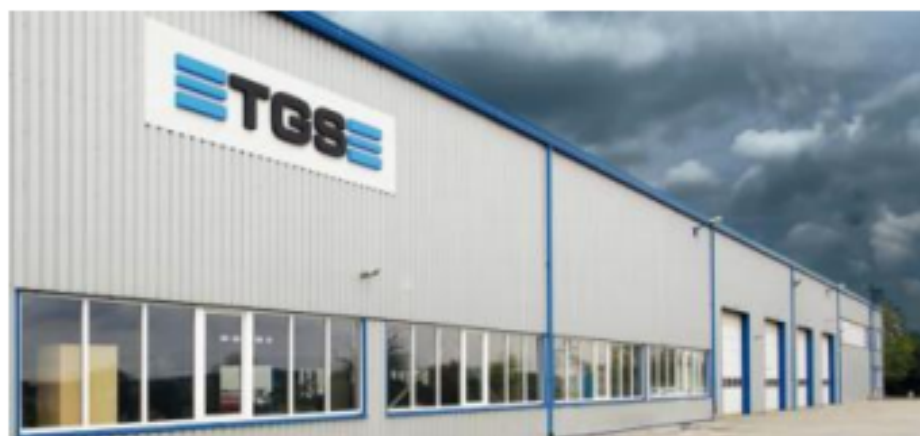
Obr. 3.1 Areál společnosti TGS Zdroj: Archiv společnosti TGS.
