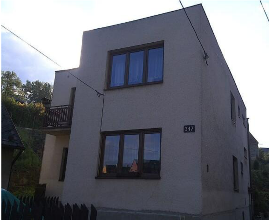
Obrázek 13: Rodinný dům č.4 - po rekonstrukci
