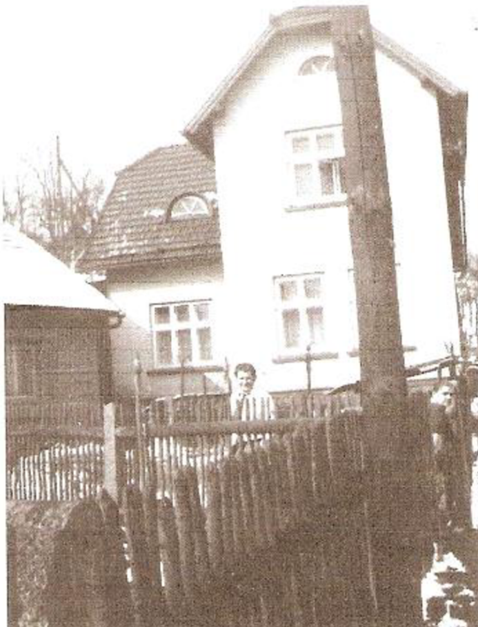
Obrázek 11: Rodinný dům č. 4 - před rekonstrukcí
