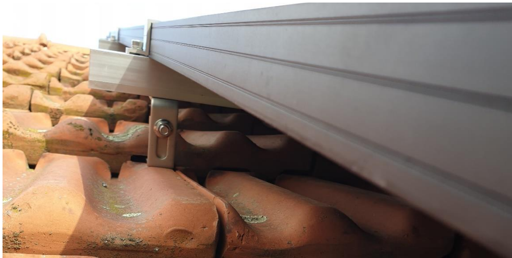
Obrázek 17 – Uchycení nosníků pomocí háků (Zdroj: vlastní)
