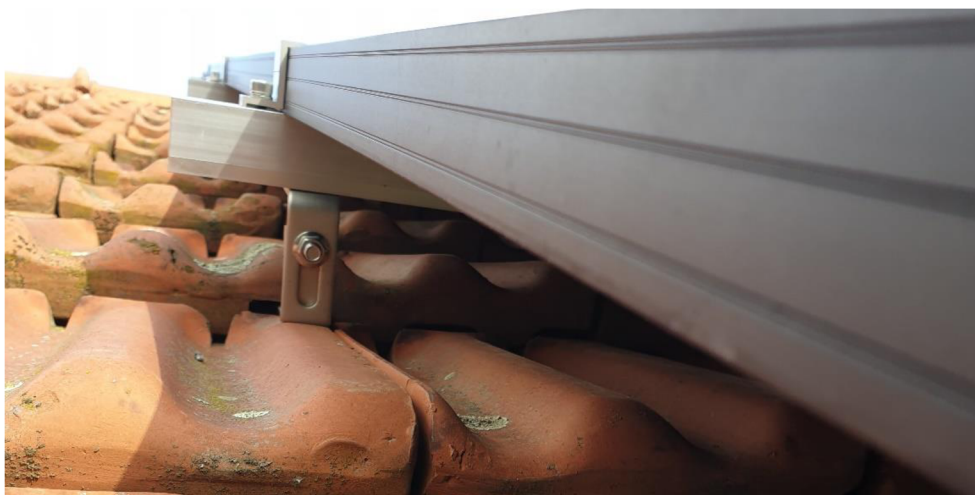
Obrázek 17 – Uchycení nosníků pomocí háků (Zdroj: vlastní)
