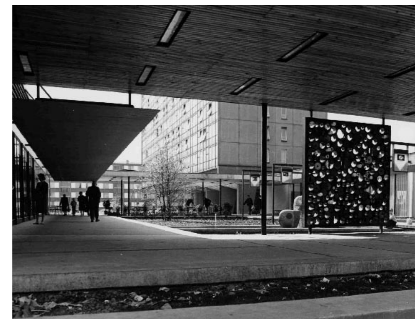
Obr. 1 Nedochovaná část sídliště Invalidovna, ukázka práce s lidským měřítkem
