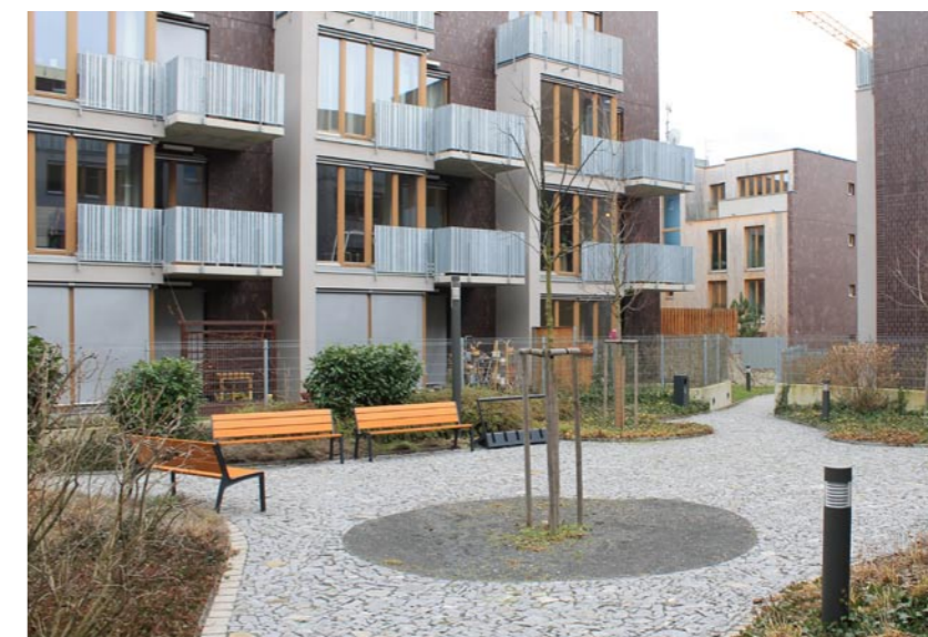
Obr. 5 Obytný soubor Na Vackově, Okružní veřejná trasa
