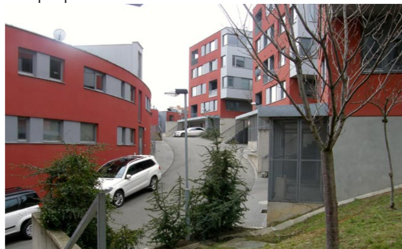
Obr. 9 Obytný soubor Na Červeném kopci
