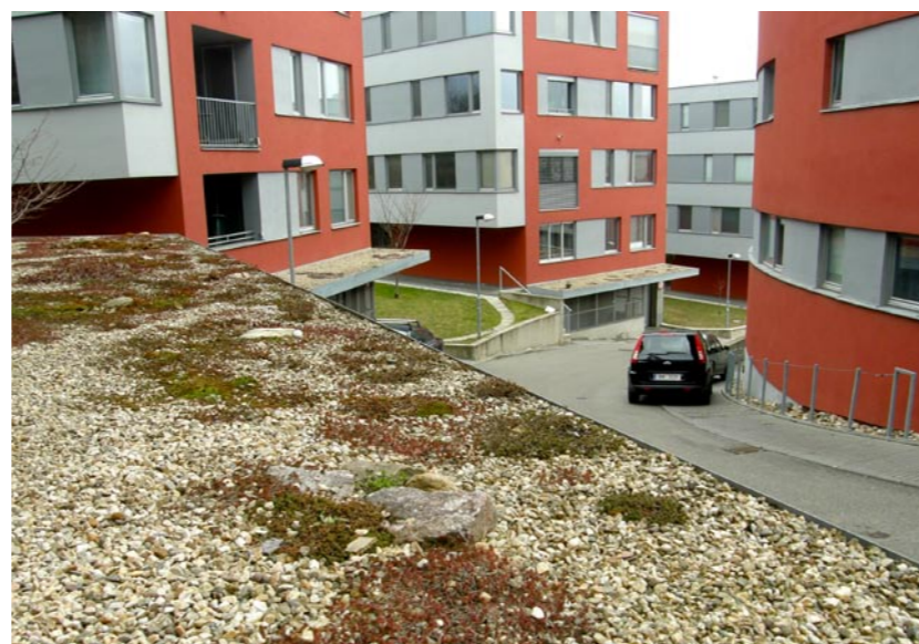
Obr. 8 Obytný soubor Na Červeném kopci Bytové domy na Červeném kopci
