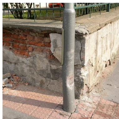
Obrázek 5 - pohled na dřecí stopu na sloupu VO
