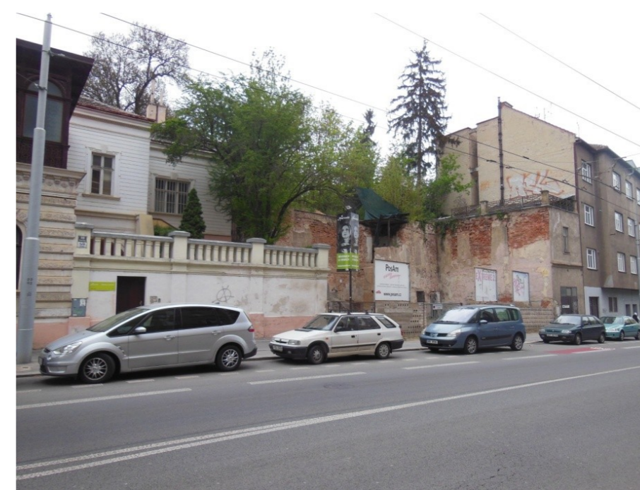
Obr. 60 Stávající stav proluky v ulici Hlinky
