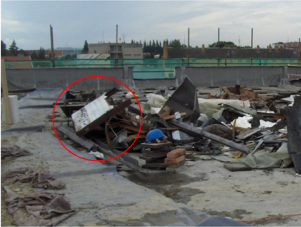
Obr. 32 Nedodržování technologických postupů při manipulaci s materiály obsahující azbest
