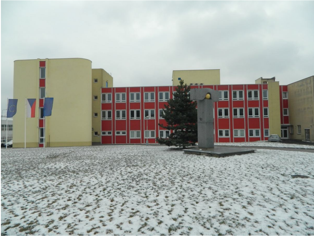
Obr. 41 Revitalizace systémem stěnových panelů
