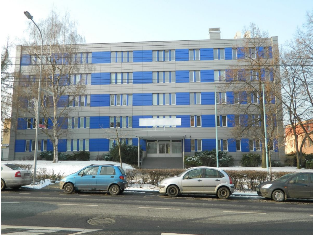
Obr. 37 Revitalizace systémem plechových kazet
