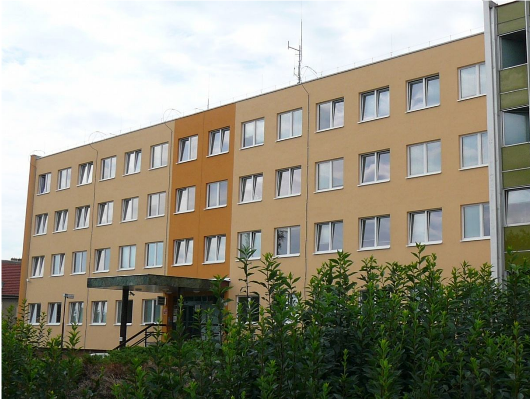
Obr. 45 Revitalizace pórobetonovými tvárniciemi
