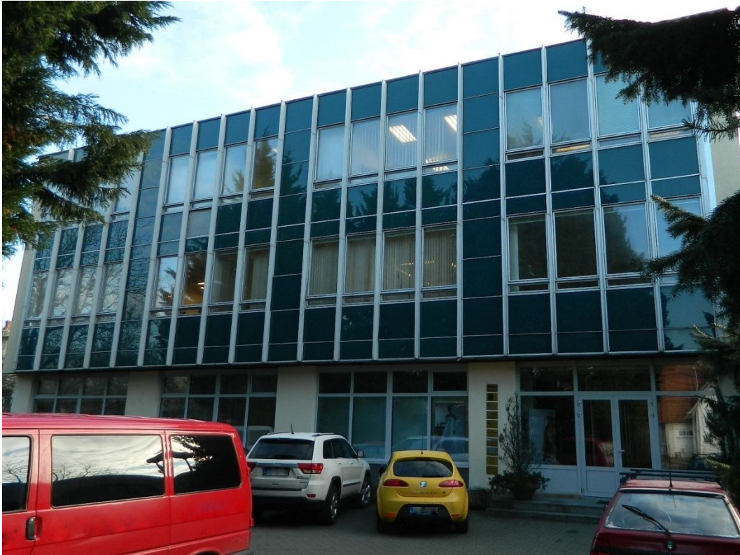
Obr. 29 Původní konstrukce OD-001 „Boletický panel“
