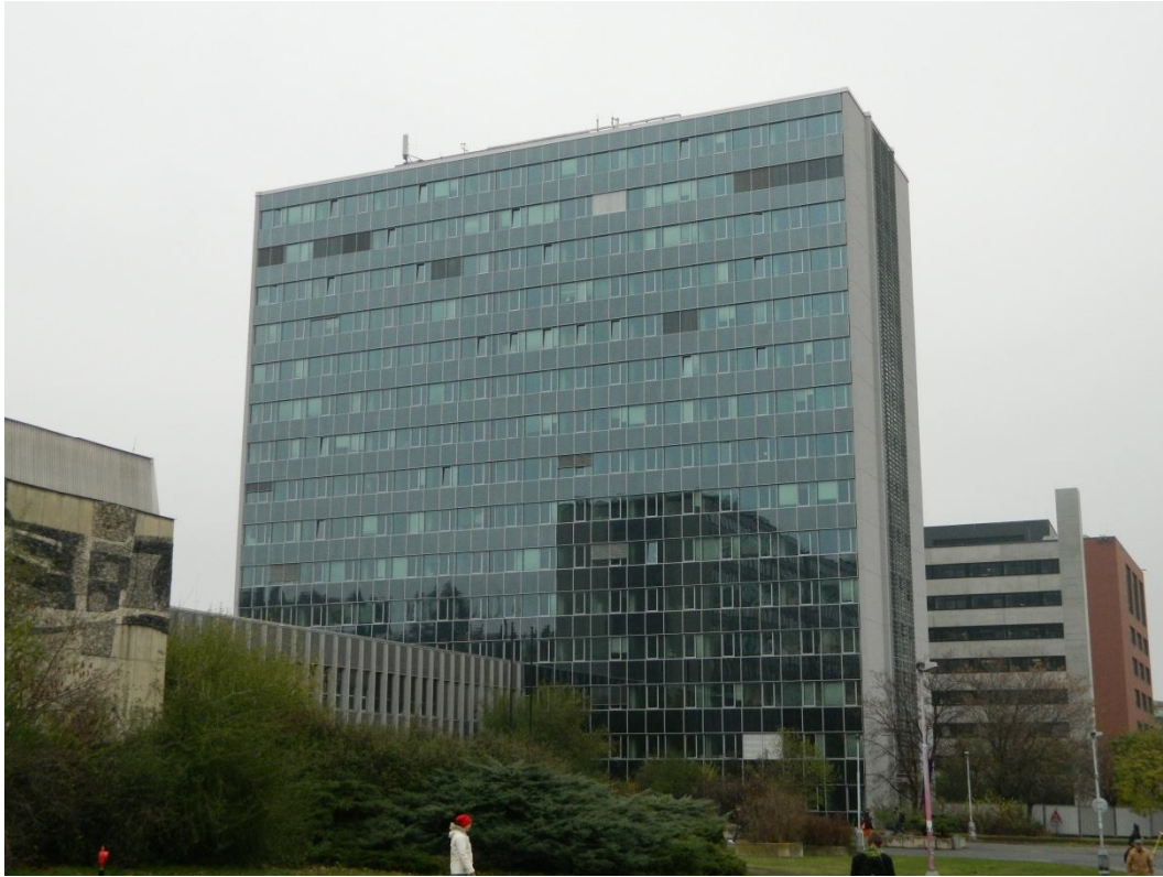
Obr. 43 Revitalizace elementy panelů
