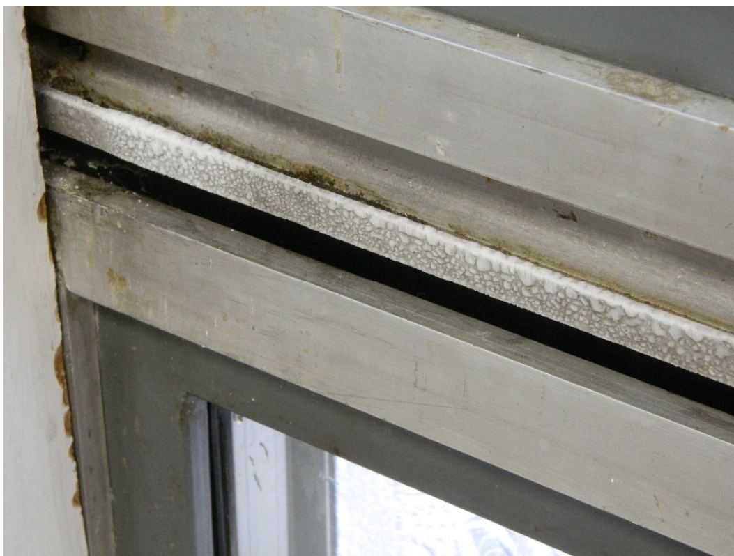
Obr. 55 Námraza na okenním rámu opláštění OD-001 [110]
