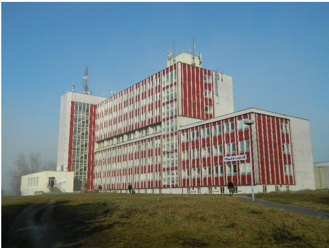
Obr. 33 Výměna transparentní „okenní“ části obvodového pláště
