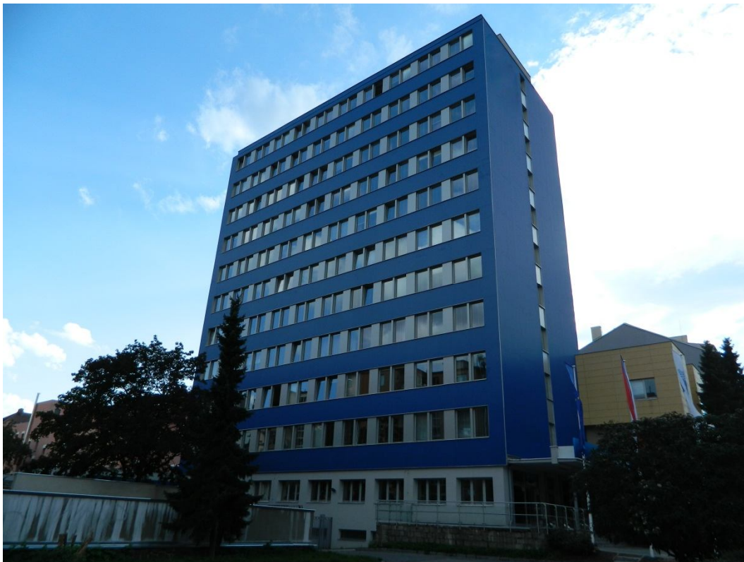
Obr. 35 Revitalizace systémem vlnitých plechů
