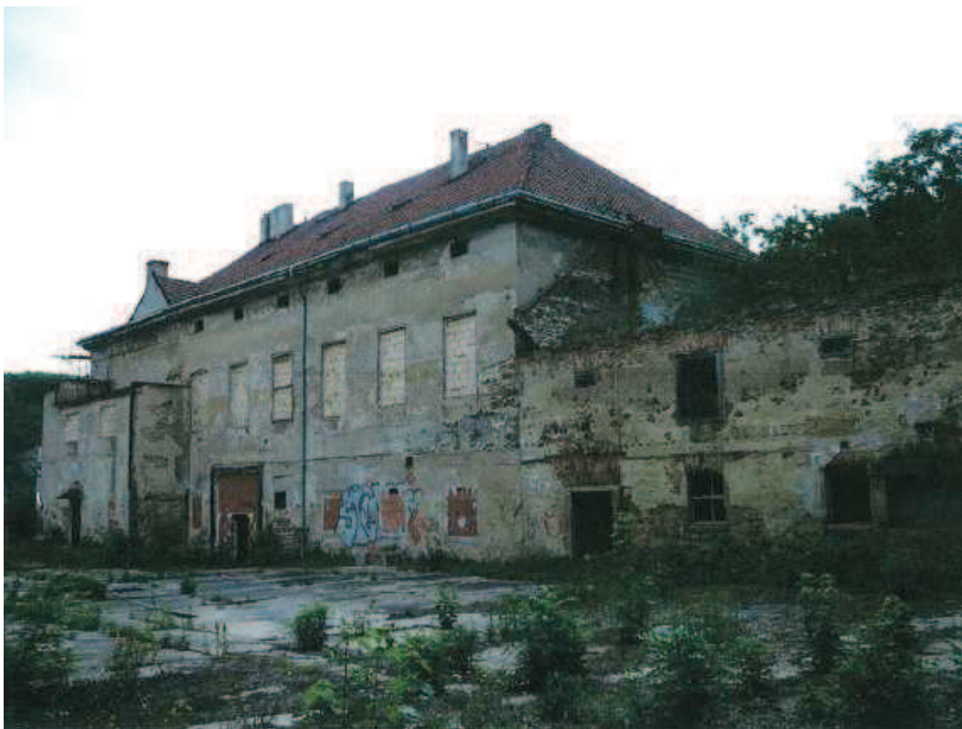
Obr. 8 Dvorní průčelí (Krušinová, 2007)
