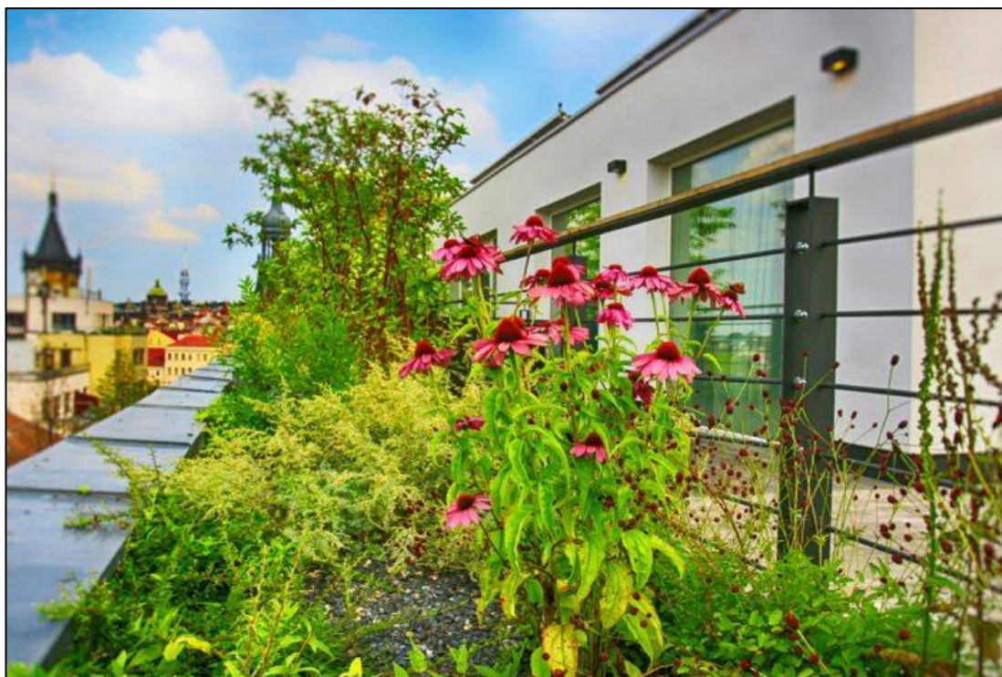
Obrázek 12: Střecha hotelu Mosaic House (archiv atelieru Flera, 2019).
