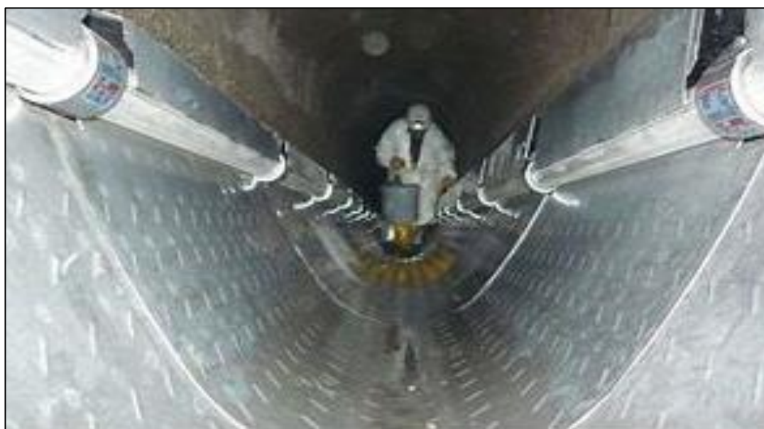
Obrázek 24: Detail použitého modulu kanalizačního výměníku ve stoce (Australian Energy Agency, 2014).
