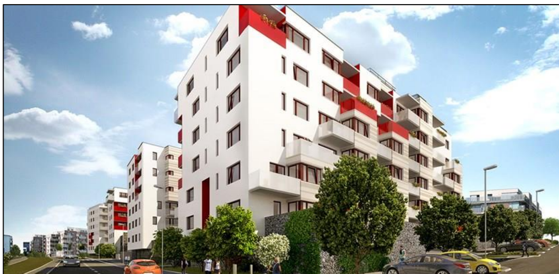
Obrázek 17: Bytový dům Botánica K (Skanska, 2019).
