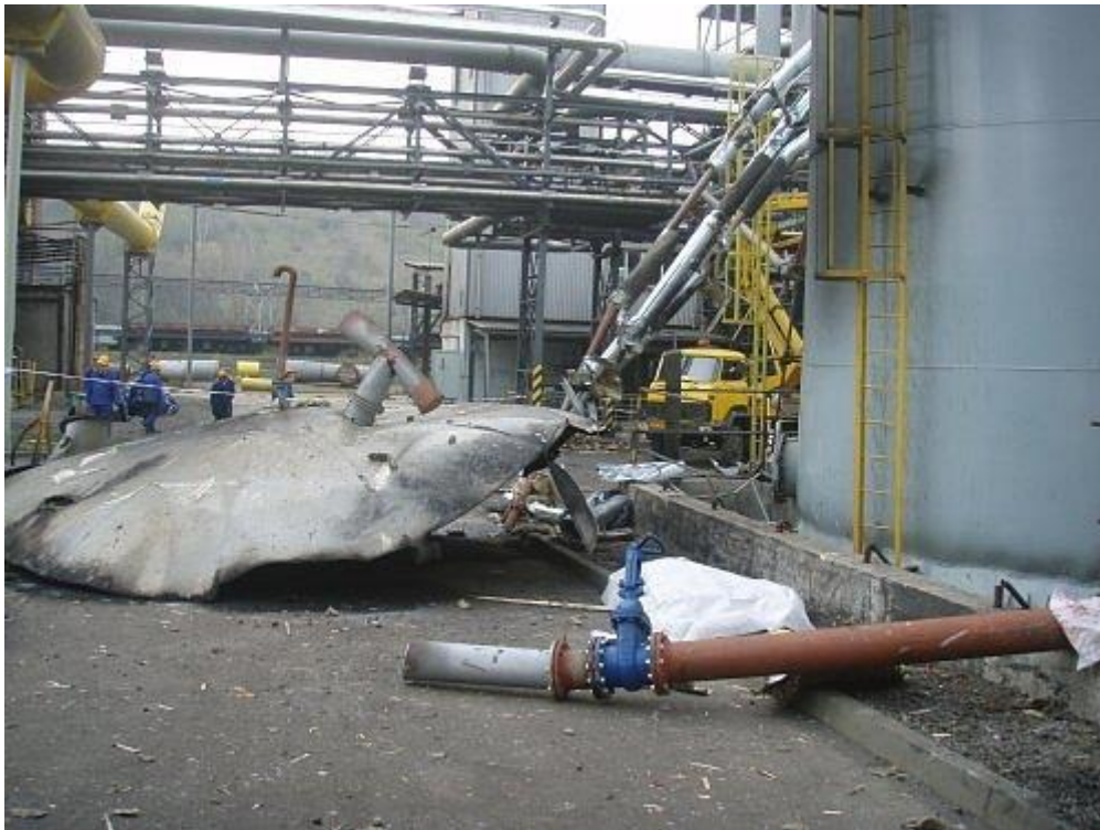
Obr. č. 10 – Výbuch nádrže se zbytkovou čpavkovou vodou [24]
